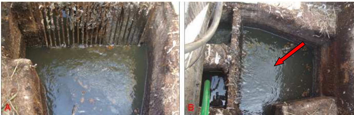
A) Gradeamento após o ponto da coleta. B) Seta indicando o local da coleta, onde é colocada a bomba de sucção.
