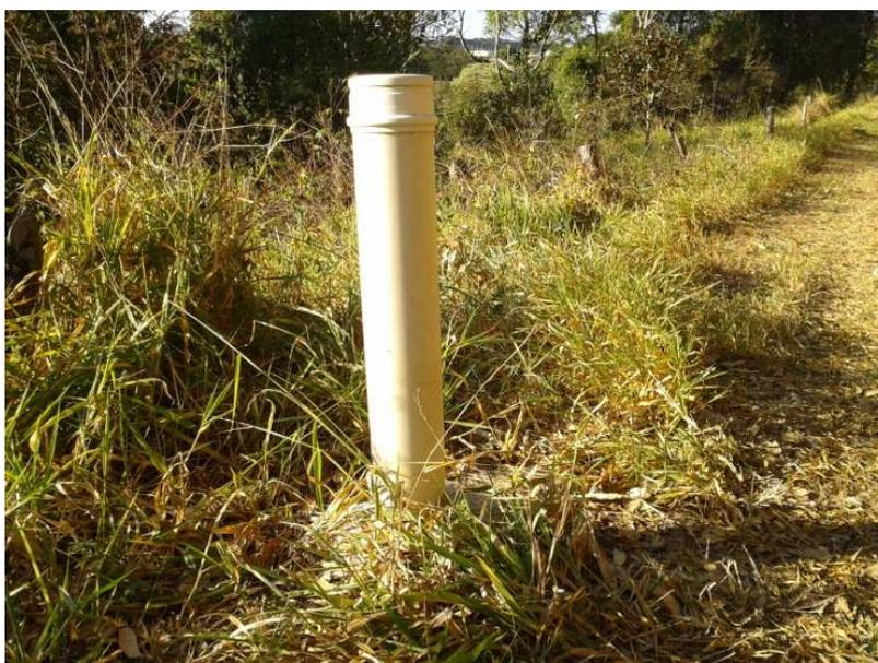
**Figura 4.5** - Poço de monitoramento de água subterrânea instalado a jusante da área experimental
