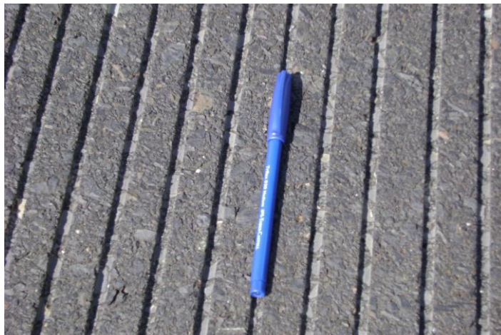
Figura 3.14 - Concreto asfáltico com grooving na superfície (arquivo próprio)
