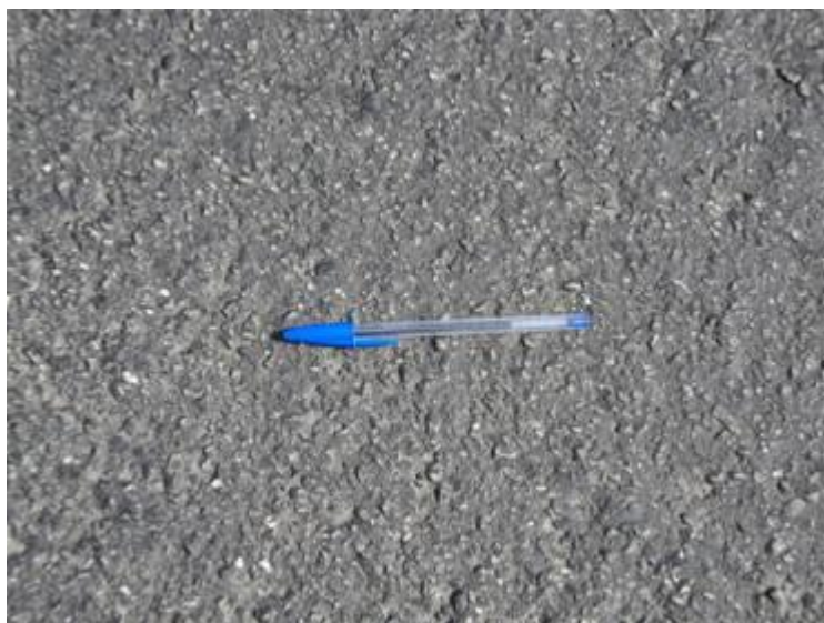
Figura 3.13 - Micro Revestimento Asfáltico (arquivo próprio)
