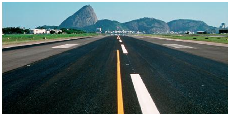
Figura 3.4 - Camada Porosa de Atrito executada no Aeroporto Santos Dumont - RJ (BERNUCCI et al, 2008)
