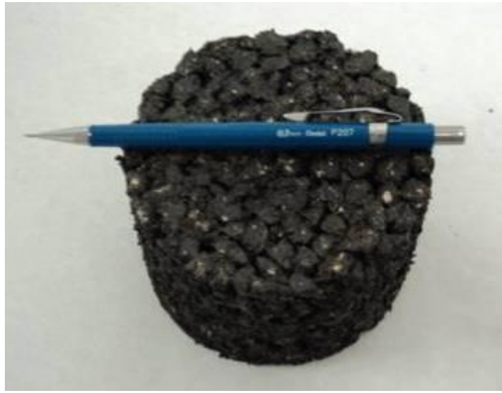
Figura 3.3 - Corpo de prova extraído de revestimento tipo CPA – graduação aberta (arquivo próprio)
