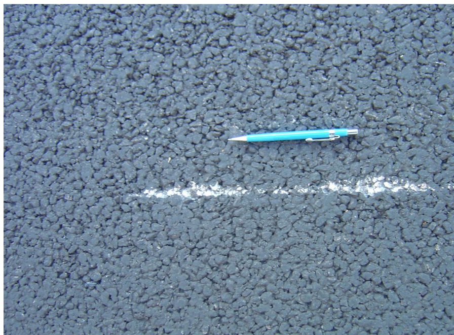
Figura 3.8 - Aspecto de uma camada de SMA (arquivo próprio)
