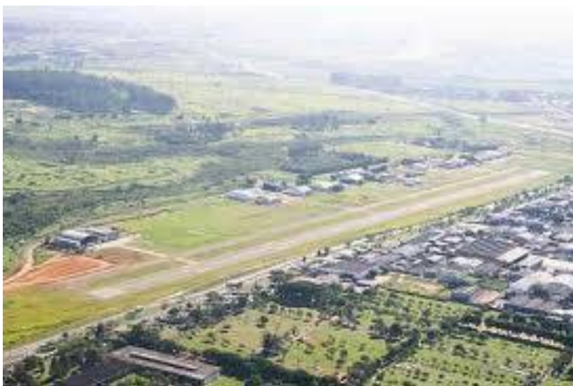
Figura 6.11 – Vista aérea do Aeroporto Estadual Campo do Amarais (DAESP, 2012)
