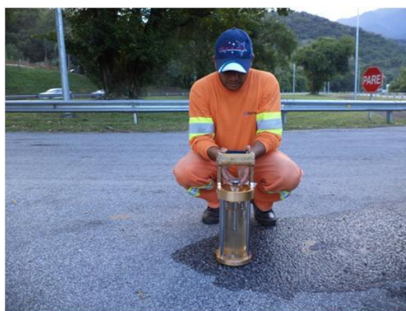
Figura 6.8 - Execução do ensaio com o outflow meter no micro revestimento asfáltico
