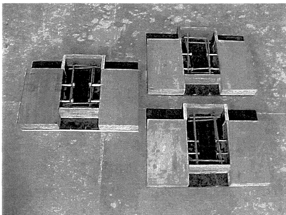
FIGURA 4.4 - Corpos-de-prova antes da concretagem.
