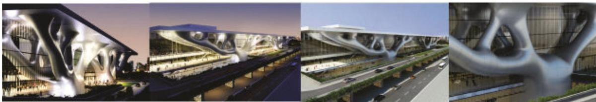
a) Nota: a, b, c) ramos das “árvores” com o pano de vidro no meio; d) detalhe do pilar em forma de tronco de árvore.
