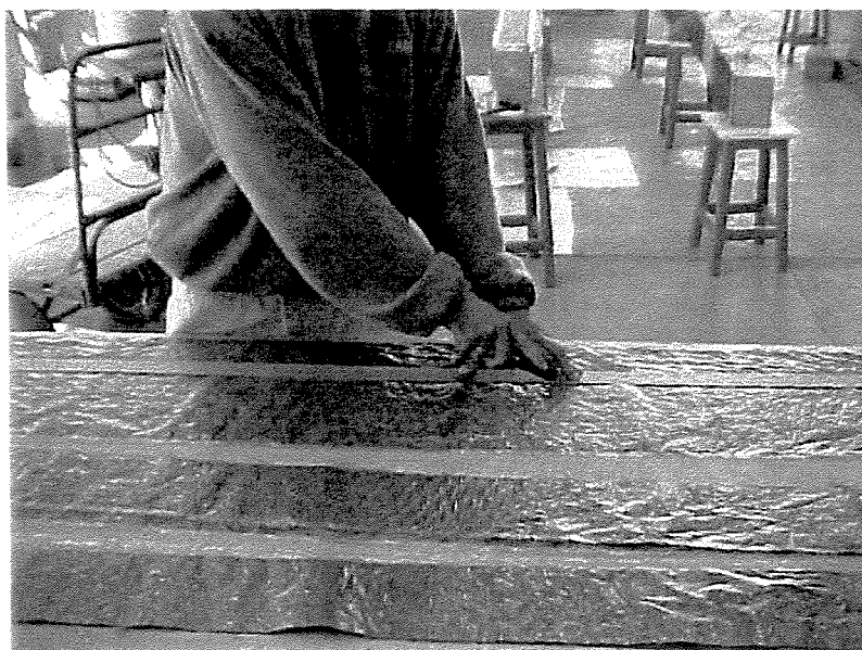
Figura 4.18 - Corte da manta de PRFC.
