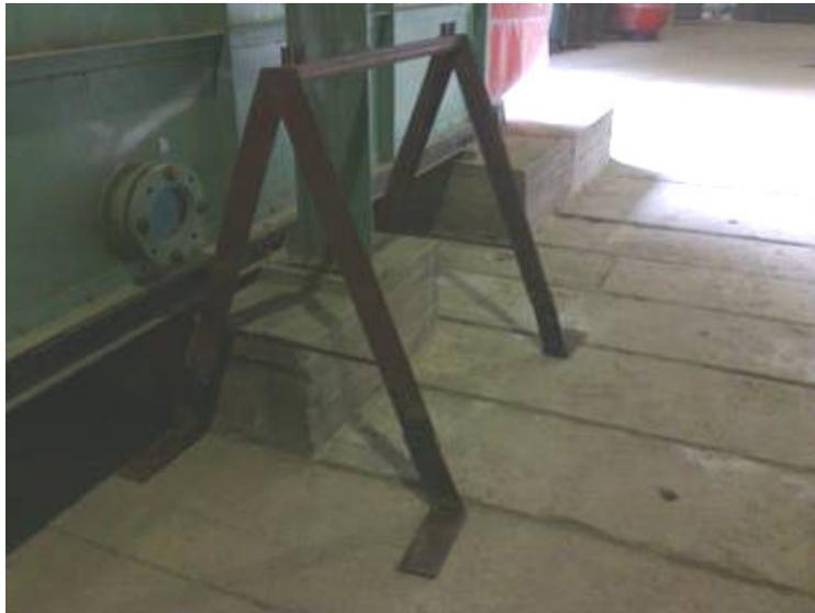
O cavalete da Figura 47 foi posicionado invertido no canal de forma que as sapatas se apoiassem na borda no canal e os pinos guiassem os cabos, conforme a Figura 48.
