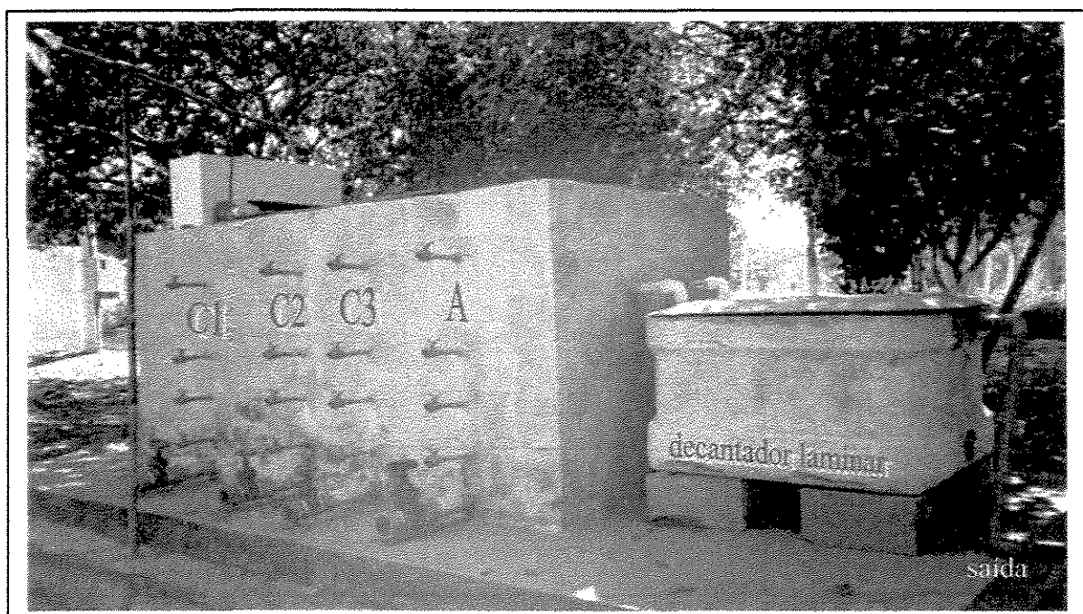
Figura 4.7 – Reator compartimentado híbrido anaeróbio/aeróbio
