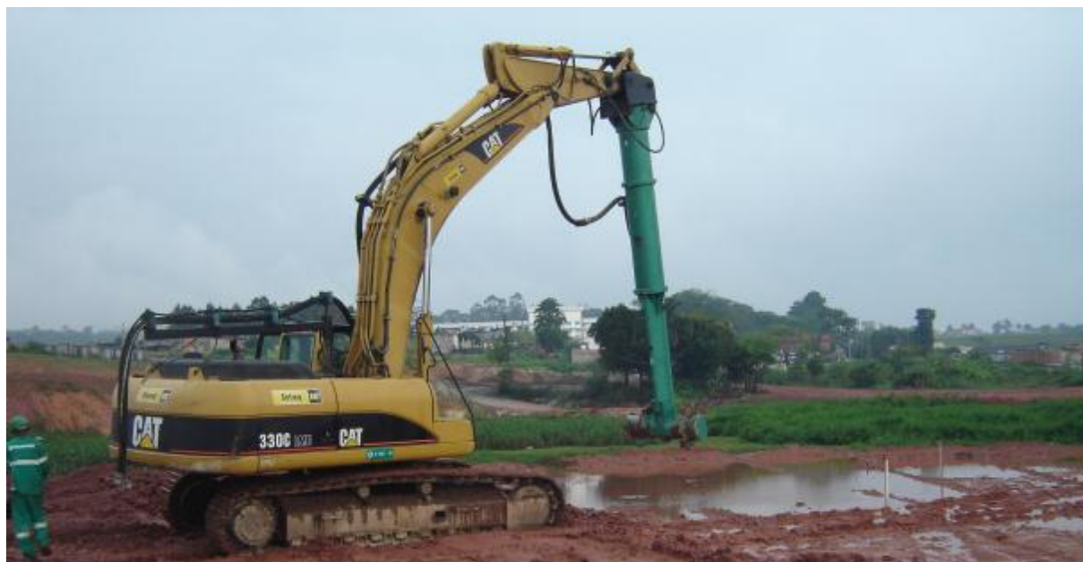
Figura 3. 2 – Multimisturador acoplado ao braço da escavadeira Fonte: (arquivo pessoal)
