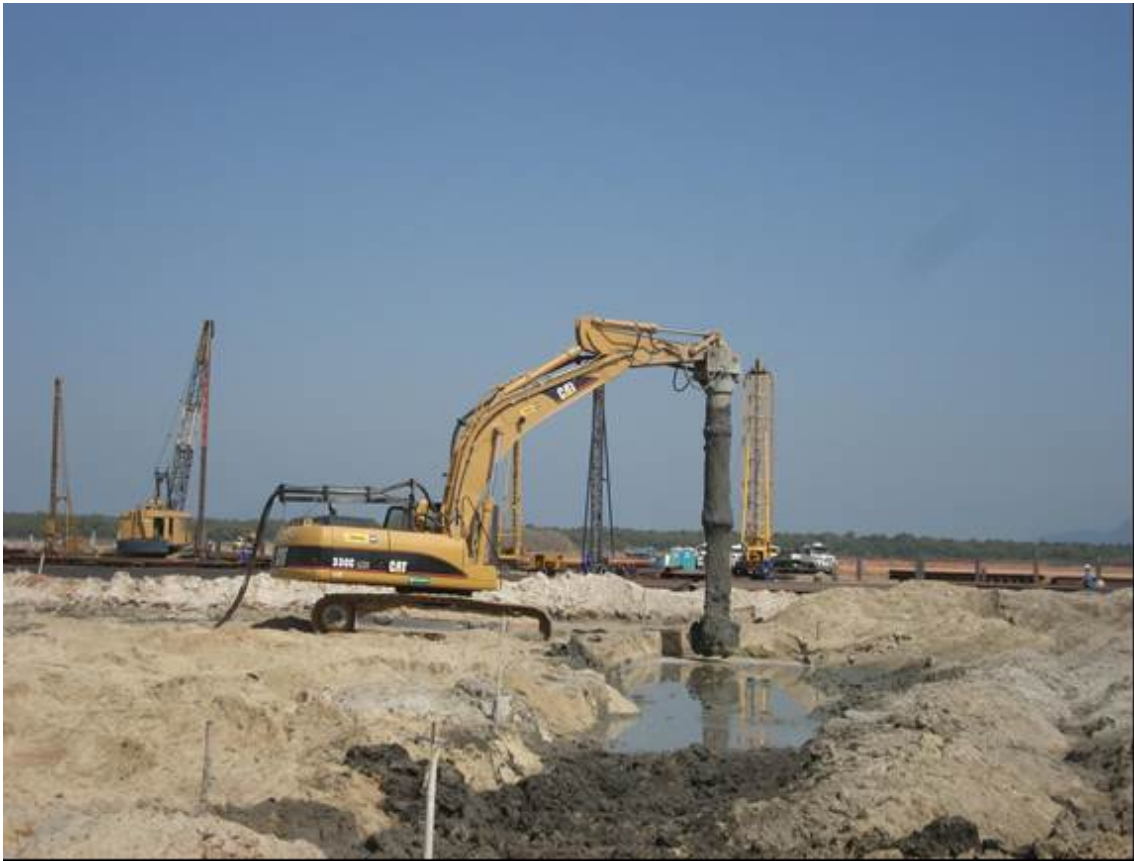
Figura 3. 8 – Vista da obra Sepetiba – RJ Fonte: (arquivo pessoal)
