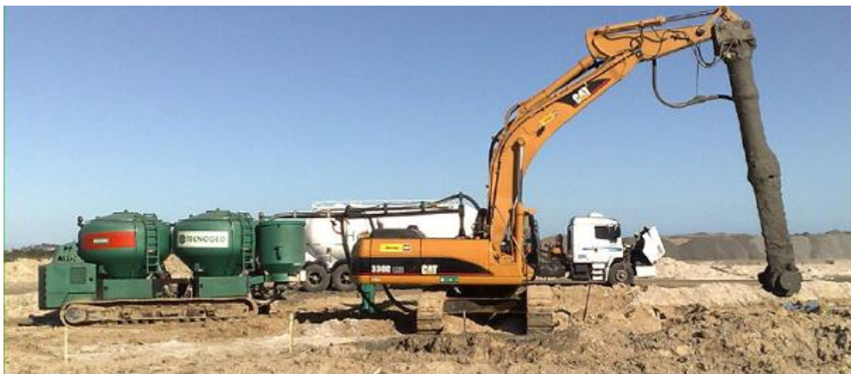
Figura 3. 3 – Sistema completo com tanques de alimentação, escavadeira e multimisturador Fonte: (arquivo pessoal)
