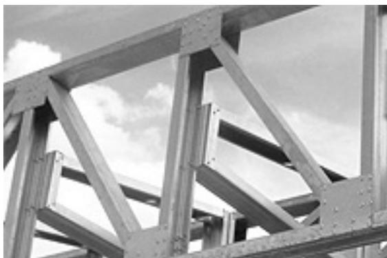
Figura 1.3 – Ligação de elementos de treliça com chapas de *gusset*
