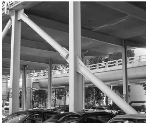
Figura 1.5 – Ligação de contraventamento em perfil tubular de seção circular – PACKER (2006)
