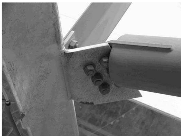
Figura 1.24 – Colapso de uma ligação com chapa de topo
