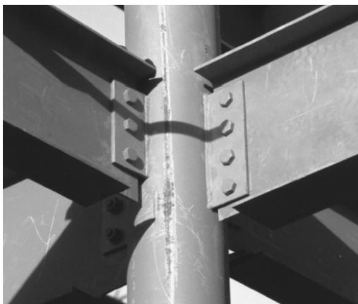
Figura 1.4 – Ligação viga-pilar com chapa de topo
