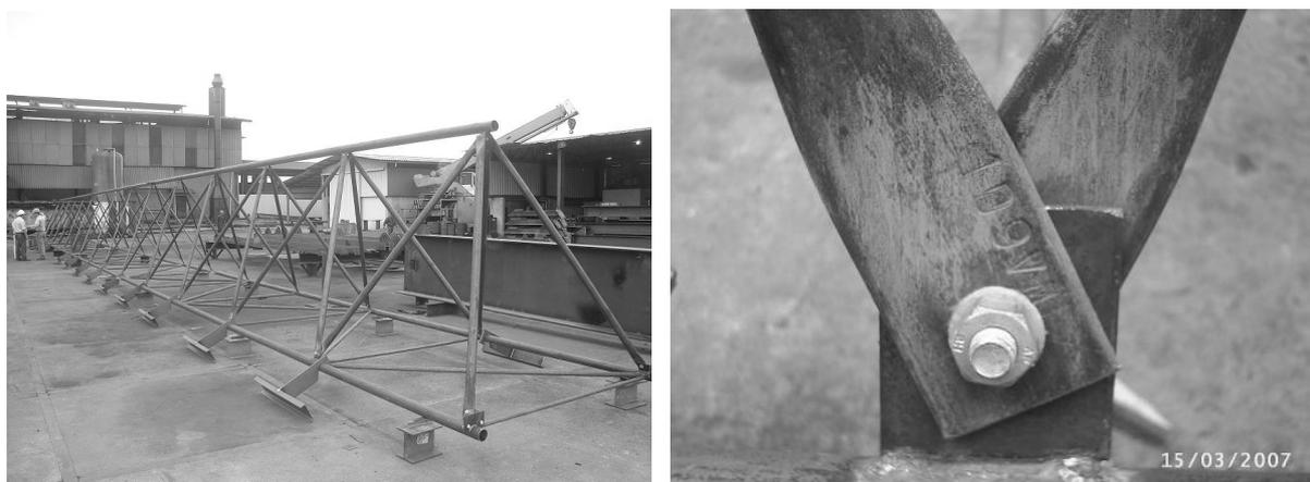
Figura 1.2 – Treliça de 30m de vão utilizando a concepção estrutural
