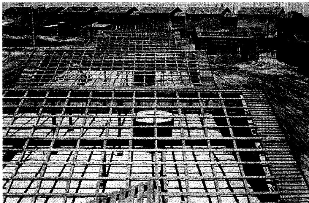
**FIGURA 5.28** - Processo construtivo utilizado na execução da estrutura do telhado das unidades habitacionais; Jd. Monte Alegre de Paulínia, Paulínia (SP) - 1999.
