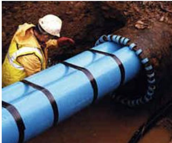
Figura 3.11: O tubo dobrado é inserido na tubulação, recuperando em seguida sua forma original.
