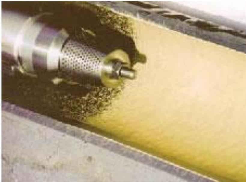
Figura 3.4: Cabeçote de aspersão de aplicação da resina epóxi
