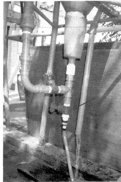
**FIGURA 4.10** Sistema de esgotamento, localizado junto a entrada de alimentação
