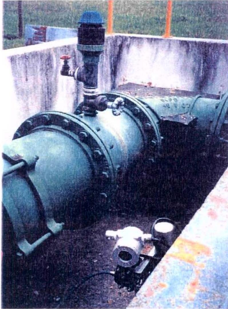
**Figura 6.2** Telecontrole de válvula a montante da Elevatória Norte da SANASA - Campinas-SP.
