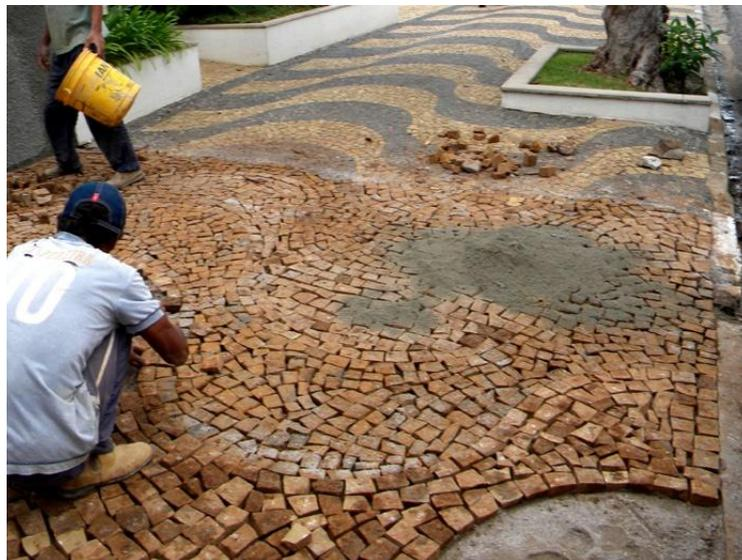
**Figura 117.** Completando a colocação das pedras para iniciar o 1º rejunte que já está sendo colocado. Campinas, SP. 2011. Fotografias da autora
