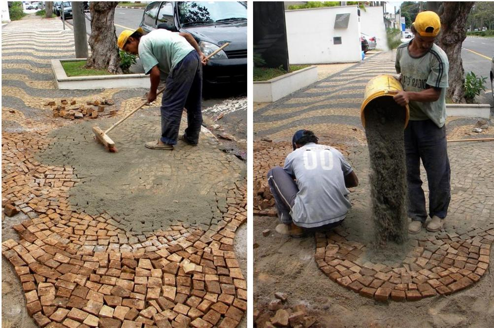
**Figura 118. A:** Varrição do 1º rejunte que penetra nos vãos entre as pedras. **B:** Colocação de material de rejunte. Campinas, SP. 2011. Fotografias da autora
