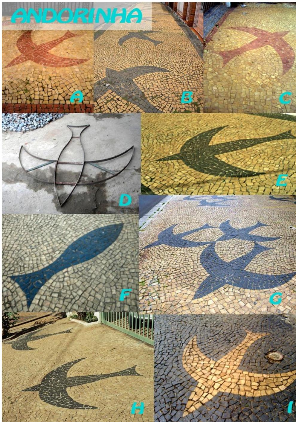
**Figura 66.** A, B, C, e E: Padrão *revoada* de andorinhas e derivações cromáticas. D: Forma/molde/gabarito. F: Derivação formal: Peixe, desenho feito a partir do gabarito do corpo da andorinha, sem utilizar os gabaritos das asas. G: Composição com três elementos. H: Motivos em positivo e I: Motivo em negativo. Campinas, SP, Fotografias da autora
