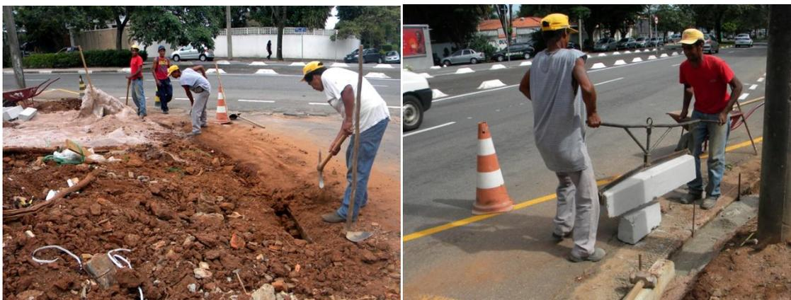
**Figura 108. A:** Preparação do terreno para colocação de guias. **B:** Colocação de guias com pegadores de metal. Campinas, SP. 2011. Fotografias da autora
