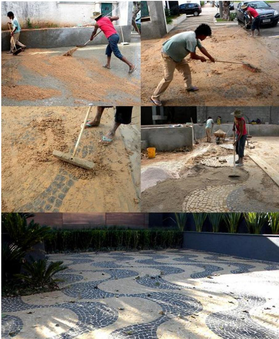
**Figura 127.** **A:** Colocação de areia para limpeza do excesso de rejunte. **B e C:** Varrição vigorosa e **D:** preparação de base para continuar o trabalho. **E:** Calçada e área de estacionamento prontos, com acabamento ajardinado (Julho 2011)<sup>28</sup>. Campinas, SP. 2011. Fotografias da autora
