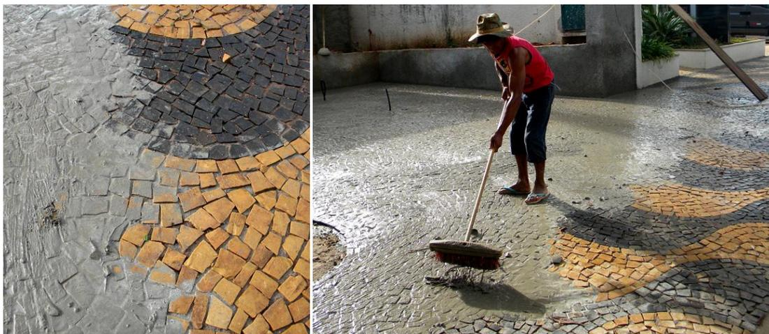
**Figura 126. A:** Detalhe do piso com o 2º rejunte sobre placa. **B:** Varrição do 2º rejunte. Campinas, SP. 2011. Fotografias da autora
