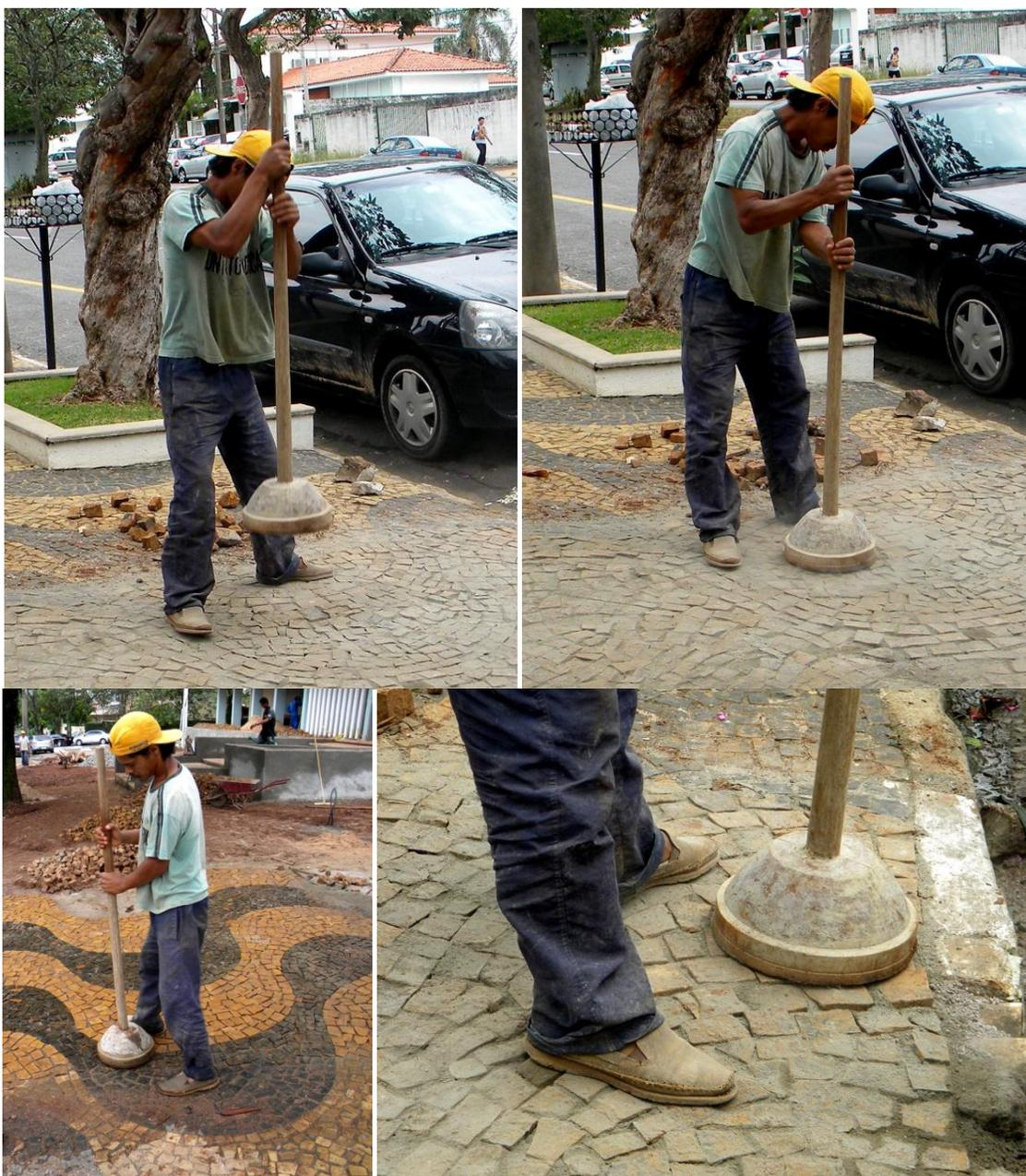
**Figura 121. A, B, C e D:** Compactação com batedor para nivelamento do conjunto. Campinas, SP. 2011.
