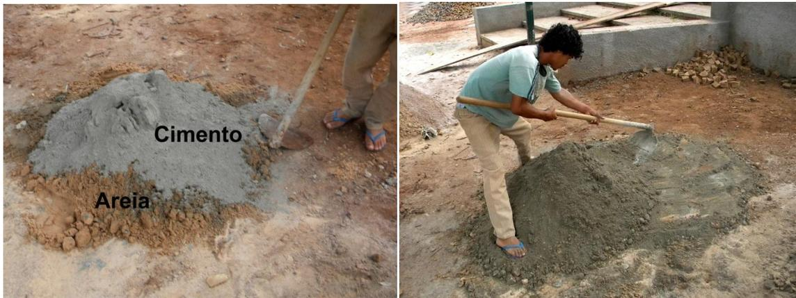
**Figura 116.** Mistura do rejunte. **A:** Traço, 1 carrinho de areia e 1 saco de cimento. **B:** Revolvendo a mistura para que fique homogênea. Campinas, SP. 2011. Fotografias da autora
