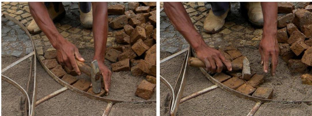
**Figura 114. A:** Ajuste da pedra. **B:** nivelamento com as pedras previamente assentadas. Campinas, SP. 2011. Fotografias da autora
