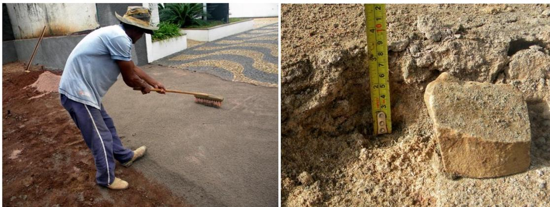
**Figura 109. A:** Preparação da base do mosaico. **B:** Espessura da base (9 cm) e pedra a ser assentada. Campinas, SP. 2011. Fotografias da autora
