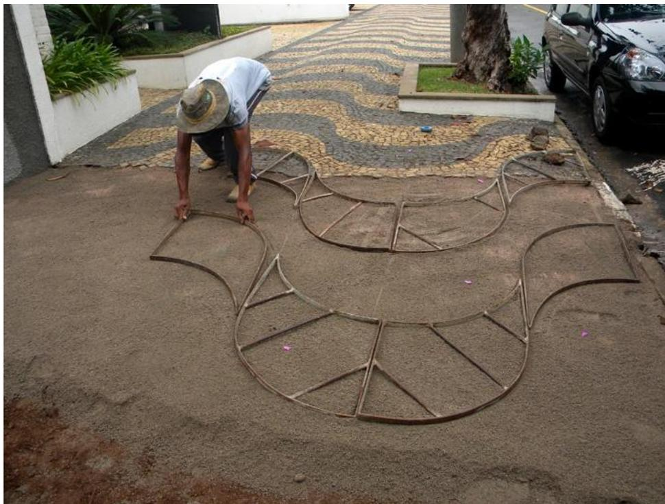
**Figura 110.** Colocação das formas (moldes/gabaritos) sobre a base seguindo desenho existente na calçada. Campinas, SP. 2011. Fotografias da autora
