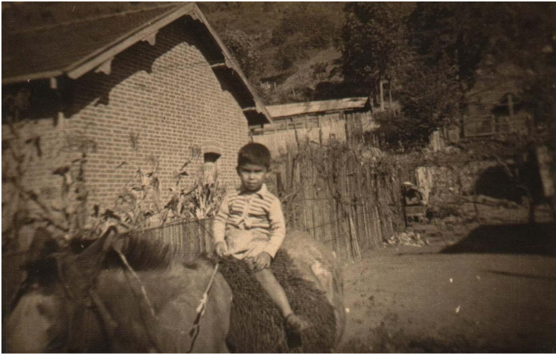
Figura 31. Poços de Caldas – Moradia dos trabalhadores da Mogiana Acervo da autora
