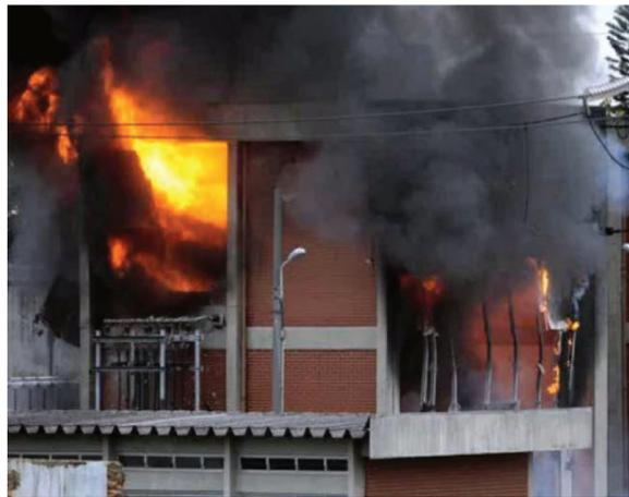
Figura 35 - Incêndio em Transformador Abridado – 1
