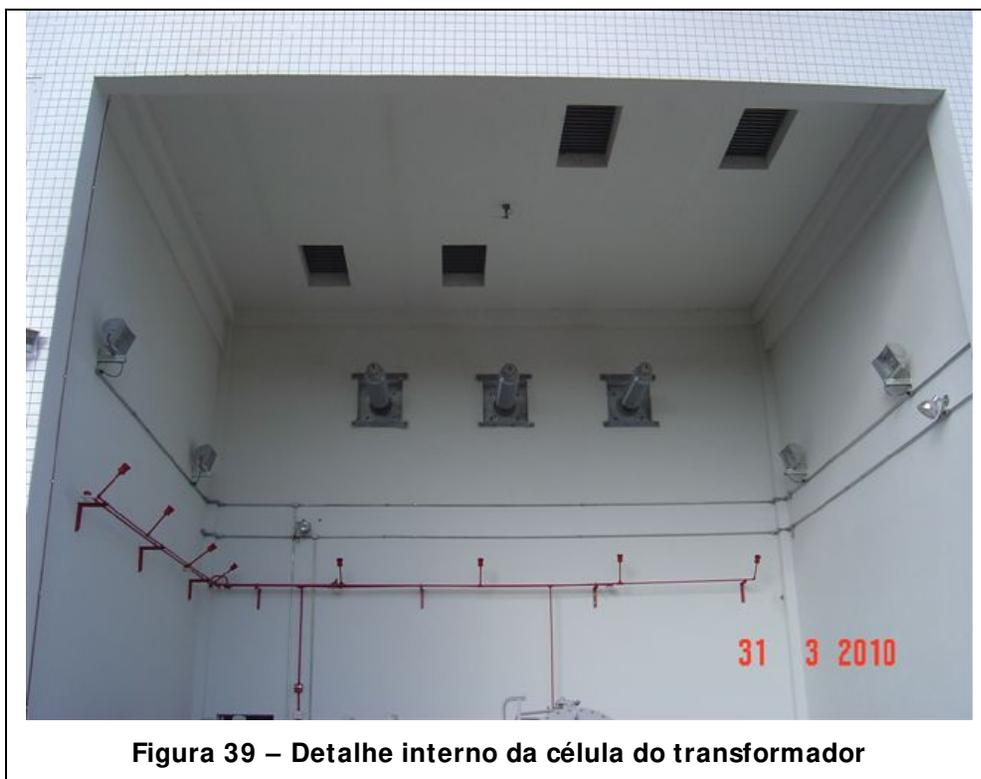
Quanto à estrutura, esta é composta basicamente por concreto armado, seja moldado in-loco ou pré-moldado, pois devido às distâncias elétricas obrigatórias (distância em que qualquer corpo esta sujeito à indução), não é possível criar uma estrutura independente, de forma que em caso de sinistro esta seja comprometida isoladamente e não a edificação como um todo.
