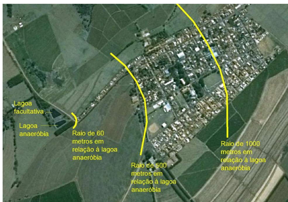
Figura 6-2 – Imagem aérea da ETE existente (base: Google Earth, 2009)
