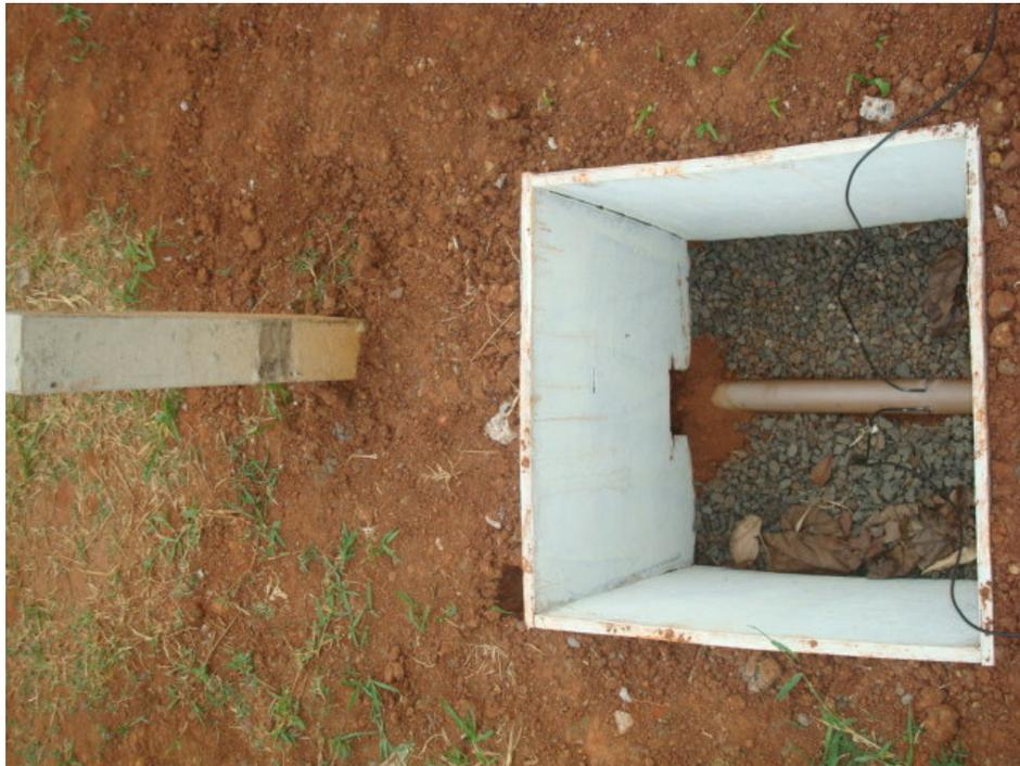
Figura A.4 - Vista da caixa de acesso instalada na linha de PVC - 50mm.
