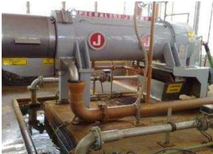
**Figura 7 – Foto centrífuga do sistema de adensamento e desidratação de lodo da ETA Taiapuêba (Sabesp)**
