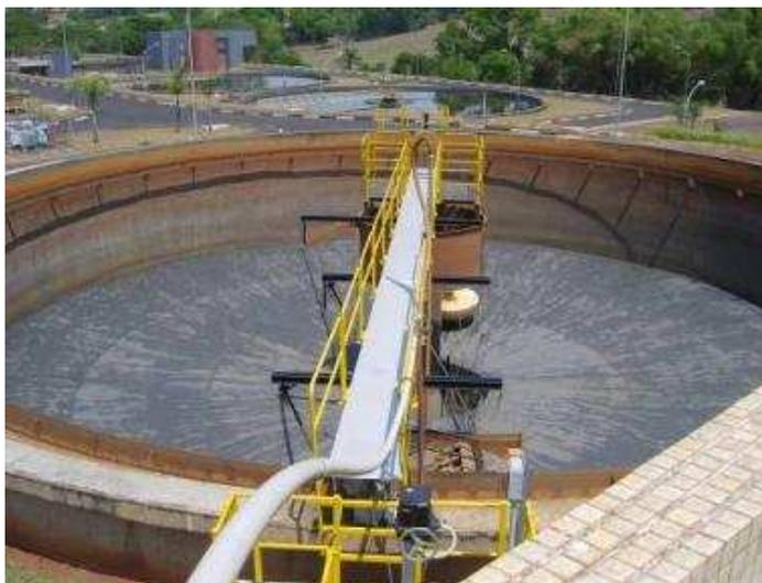
**Figura 2 – Foto adensador por gravidade Fonte: (Sabesp)**
