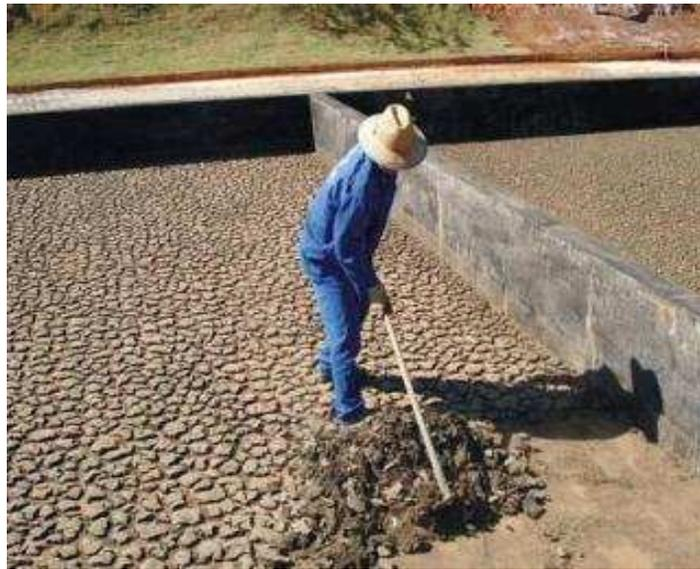
**Figura 6 – Foto de um leito de secagem Fonte: (CESAN)**
