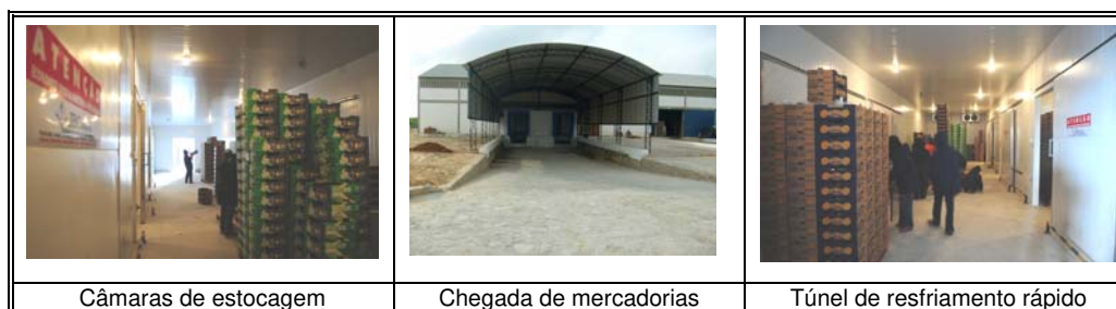
Figura 51. Câmara Fria do núcleo habitacional NH 1- centro administrativo – na planta dos lotes no Perímetro Irrigado Tabuleiro de Russas. Fornecida pelo DISTAR, em 07 de jul de 2009.
