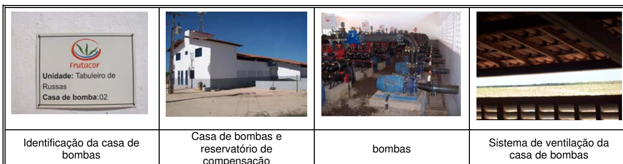
Figura 53. Casa de bomba 02 da Frutacor, no Perímetro Irrigado Tabuleiro de Russas. Fornecido pela autora, em 19 de agosto de 2009.
