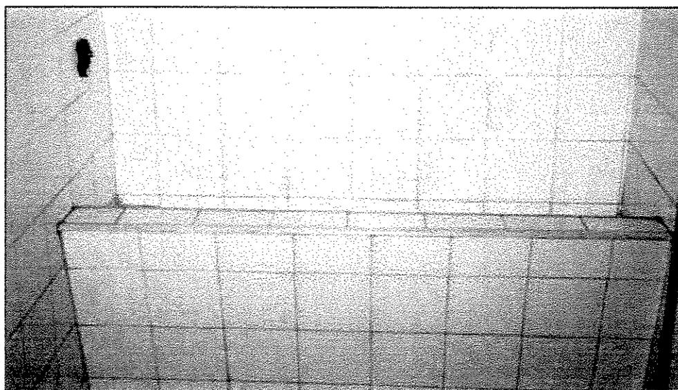
Figura 3.3: Mictório tipo calha
