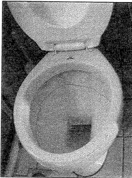
Figura 4.7: Bacia sanitária com vazamento em filete.
