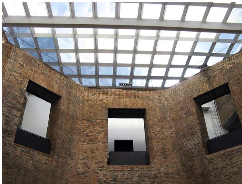
**Figura 81 - Grelhas metálicas e os vãos sem esquadrias**
