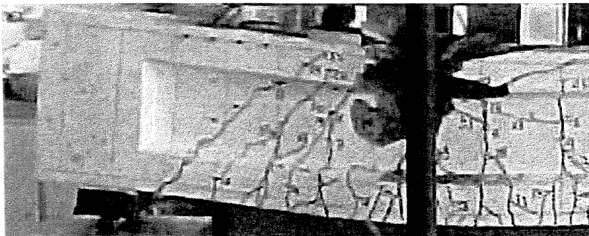
Figura 4.42 – Configuração final das fissuras na extremidade esquerda da viga - Viga I – 143 B.
