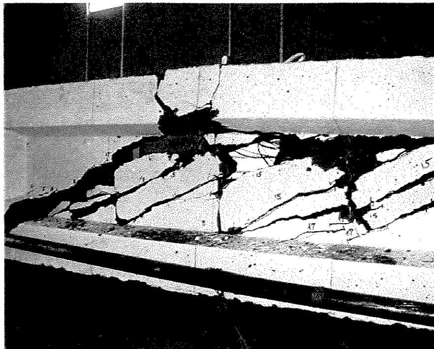
FIGURA 5.06 DETALHE DA VIGA I80-4-22-E36 ROMPIDA.
