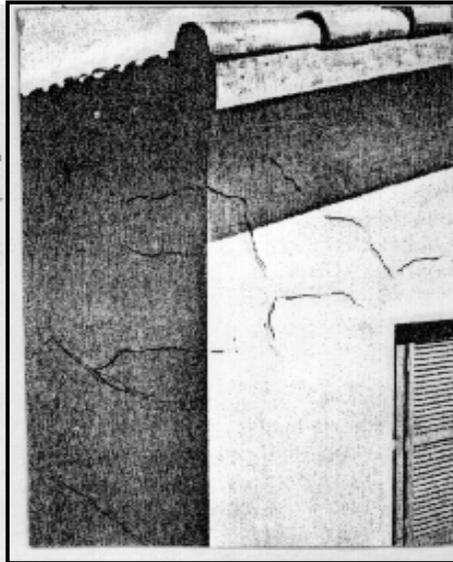
**Figura 5.8 –Fissuras mapeadas devido a retração da argamassa de base (CINCOTTO, 1983)**
