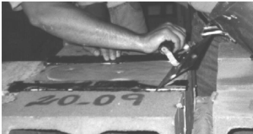
**Figura 6.10 – Aplicação e nivelamento da mistura**
