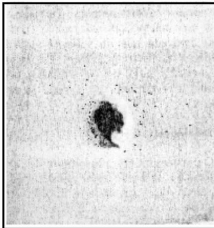
***Figura 5.6 – Vesícula formada no reboco. No centro da vesícula, material pulverulento escuro (CINCOTTO, 1983)***
