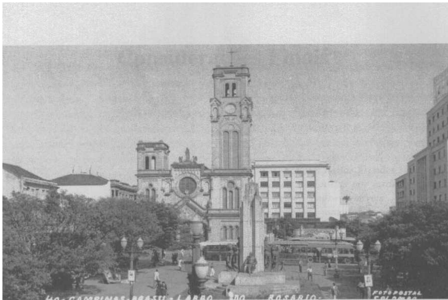
Figura 57 Fórum Pronto – Igreja do Rosário ainda não está demolida para executar Centro Cívico
