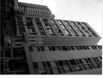
EDIFÍCIO TABATINGA Av. Francisco Pinheiro, 1328 Autor: Oswaldo Perinotto de Freitas Data: 1968
