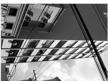
ED. CIDADE DE CAMPINAS R. Regente Feijó, 723 / Avenida das Nações Unidas, 723 Autor: Oscar Niemeyer & Valter Data: 1964
