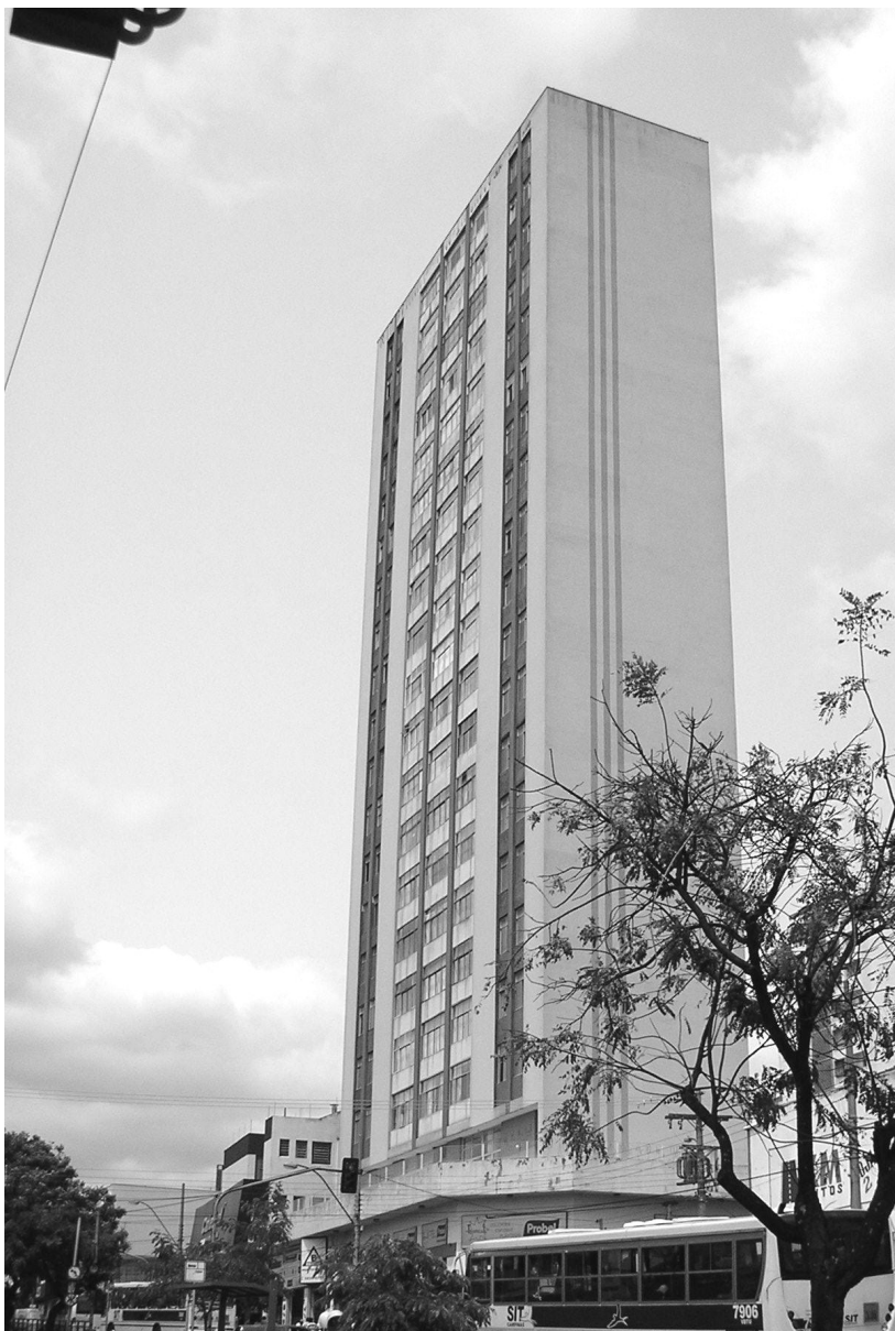
Figura 129 – Edifício Vertical Foto do Autor - 2003
