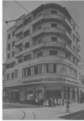
EDIFÍCIO COLUMBIA R. Barão de Jaguará, 1251 Autor: Construtora Lix da Cunha Data: 1937
