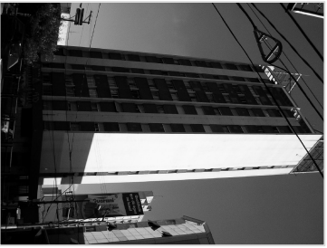
EDIFÍCIO RUI BARBOSA R. José Maria, 675 Autor: Milton Luiz Antomelli Data: 1966
