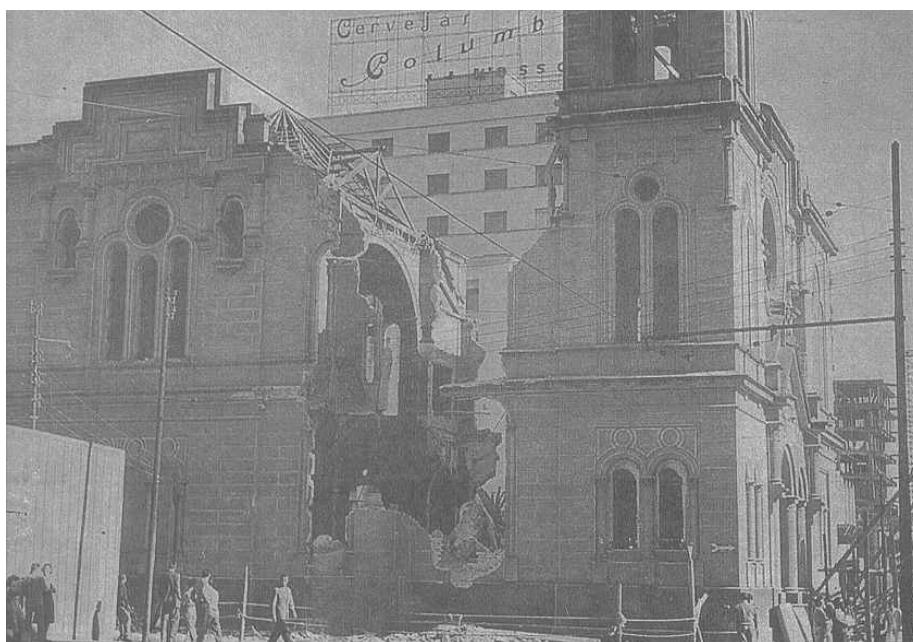
Figura 71 Igreja do Rosário em demolição – Rua Francisco Glicério (1956)
