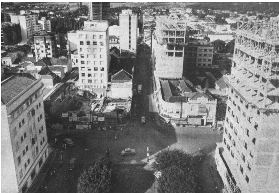
Figura 81 Vista geral da cidade - Rua Conceição – Vários edifícios em construção (1955)
