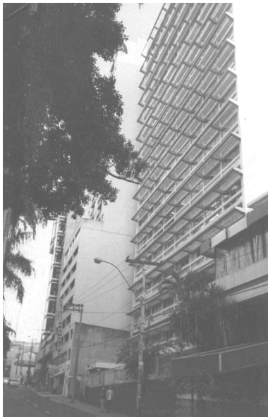
Figura 116 Detalhe protetores solares
