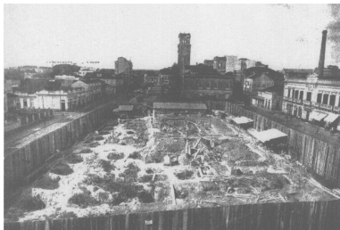
Figura 60 Canteiro de Obras para Fórum. – Década de 1940
