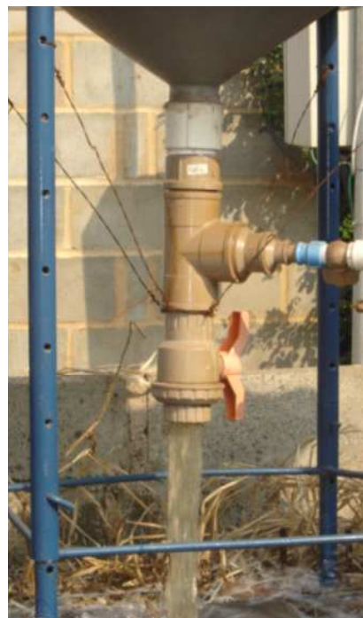
Figura 69 Realização de Descarga de Fundo
