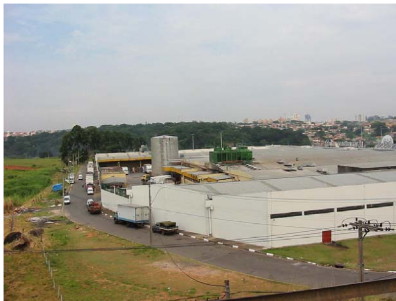
Figura 5.3.3 – Tanque de água gelada e torres de resfriamento
