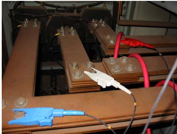
Figura 5.1.2- Coleta de dados – barramento da cabine primária
