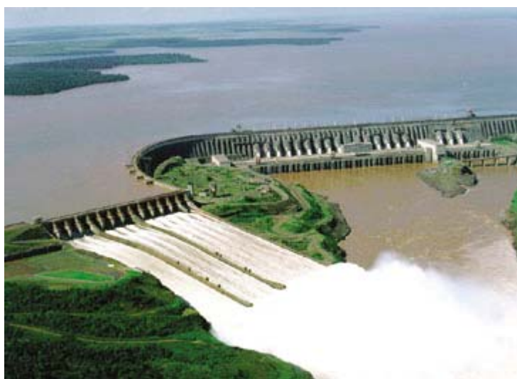
Figura 3.1.5 – Hidrelétrica de Itaipu (Brasil-Paraguai) – 14 MW
