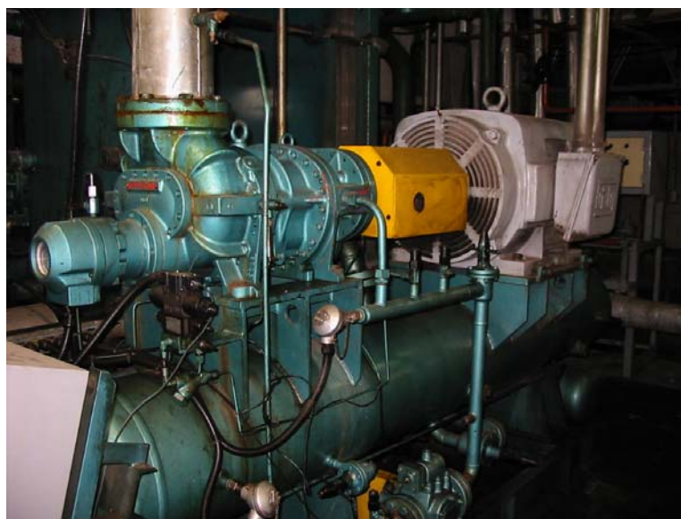
Figura 5.3.4- Chiller (resfriador) de ar condicionado
