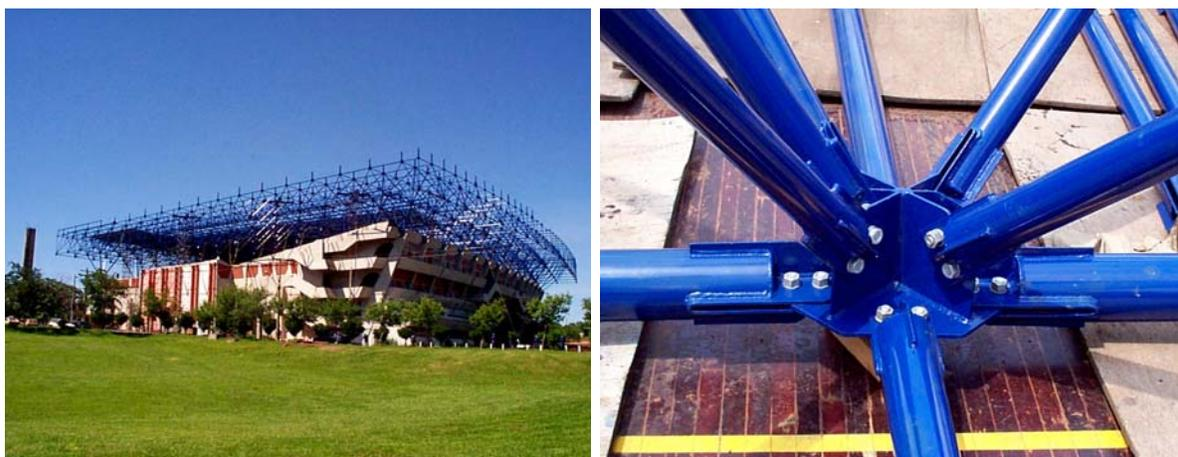
*Figura 1.01 – Ginásio UNICAMP em Fase de Montagem e Detalhe de Um dos Nós da Estrutura.*
