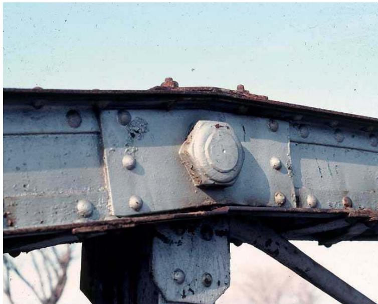
Figura 1.04 – Conexão Rotulada. FONTE: [43]
