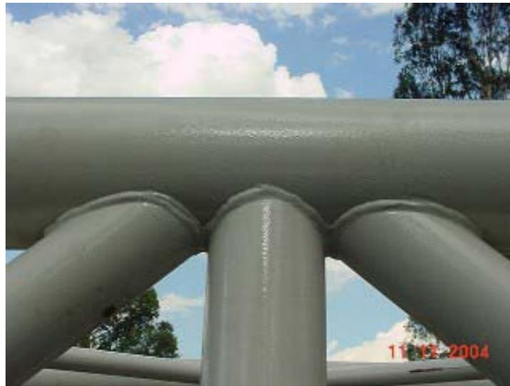
Figura 1.06 – Ligação Soldada Rígida
