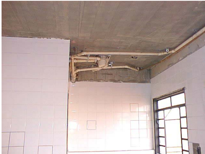
Figura 3.24 - Superfície das lajes após a retirada das formas.
