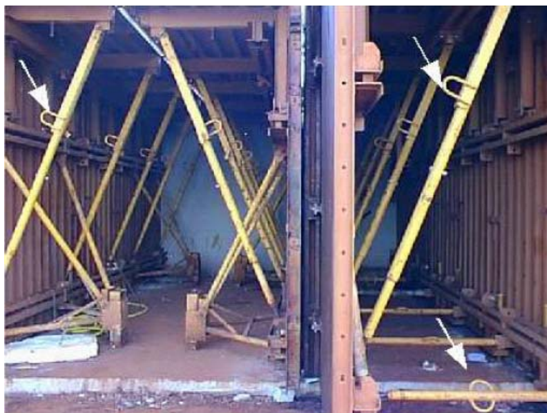
Figura 3.18 – Dispositivos para desarmar as formas.
