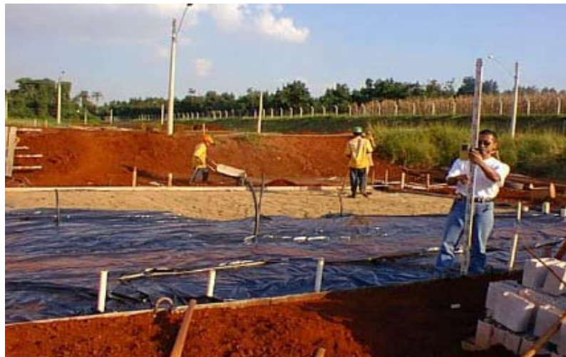
Figura 3.5 – Laje flexível - camada de areia.
