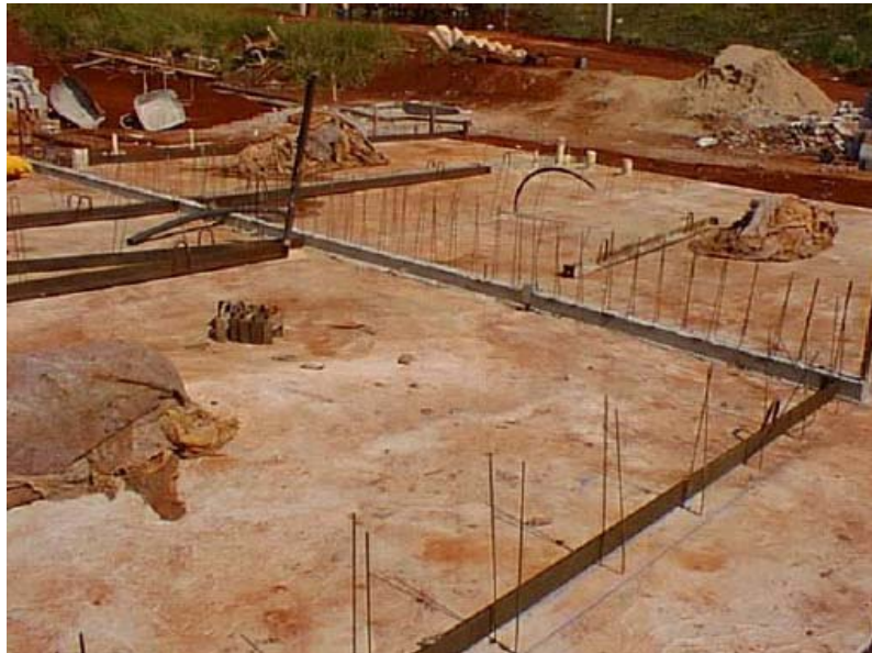
Figura 3.11 - Guias para montagem das formas.
