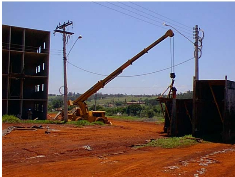
Figura 4.2 – Auto-propelido para movimentação das formas.
