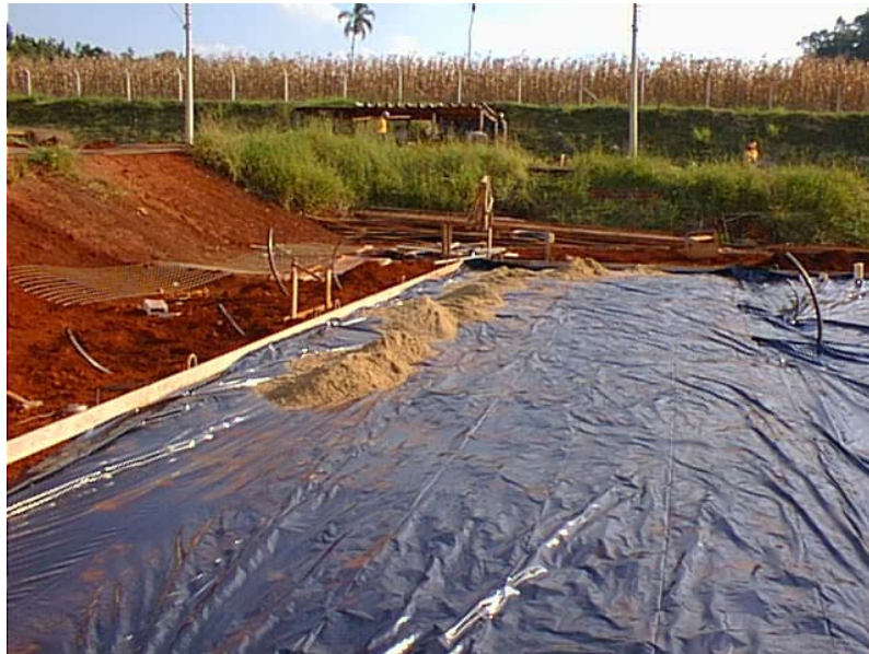
Figura 3.4 – Laje flexível - camada de lona plástica.
