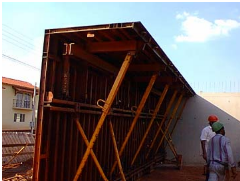
Figura 3.12 – Parede central e montagem das formas.
