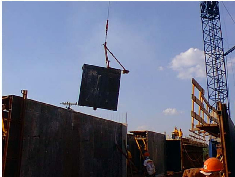
Figura 4.3 – Montagem da forma túnel.
