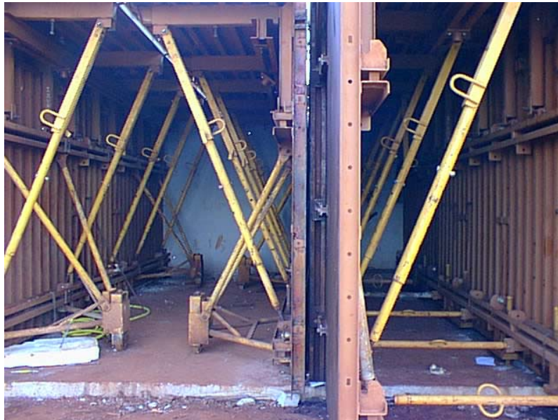
Figura 3.8 – Forma túnel - concretagem do primeiro pavimento.
