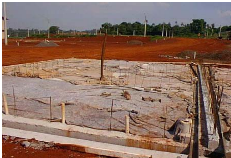
Figura 3.6 – Manta de algodão usada durante a cura.
