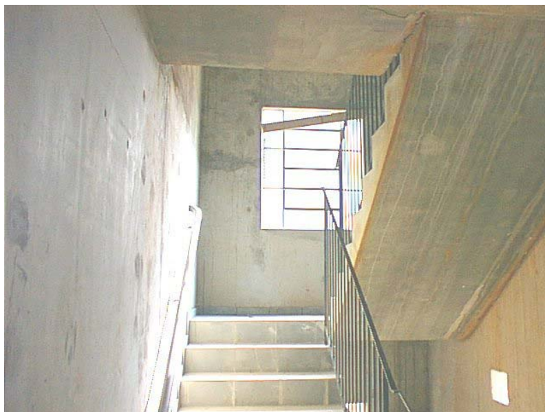
Figura 3.23 – Aspecto da superfície do concreto após a retirada das formas.
