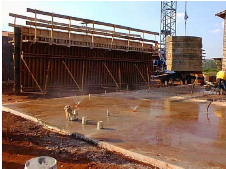
Figura 3.7 – Cura do concreto da laje flexível.
