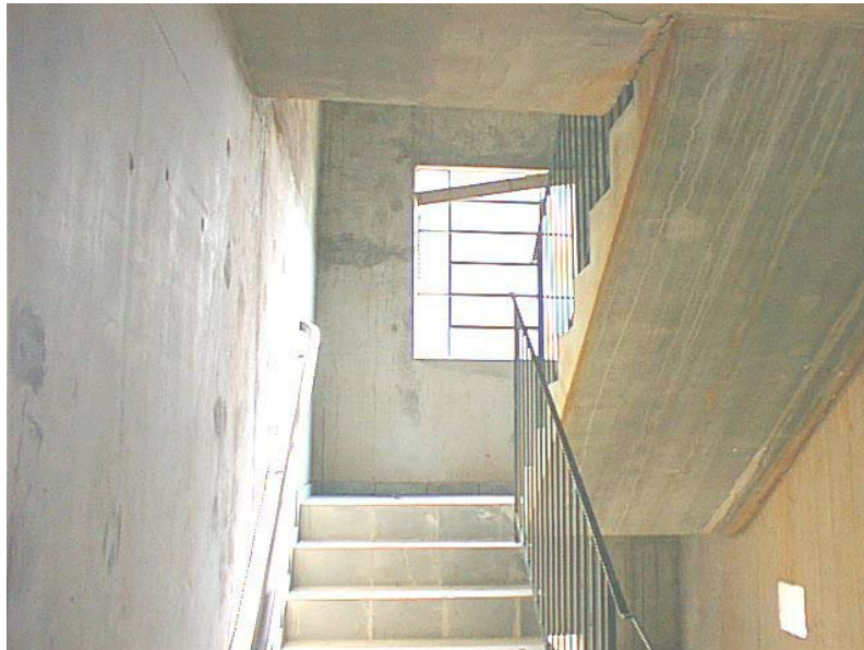
Figura 3.17 – Fixação das escadas.
