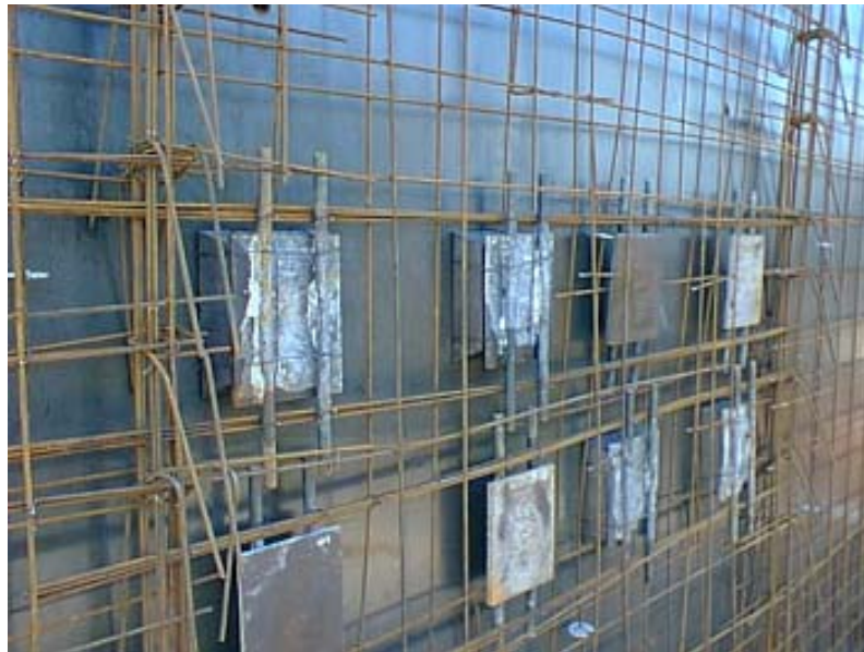
Figura 3.13 – Inserts para fixação das escadas.
