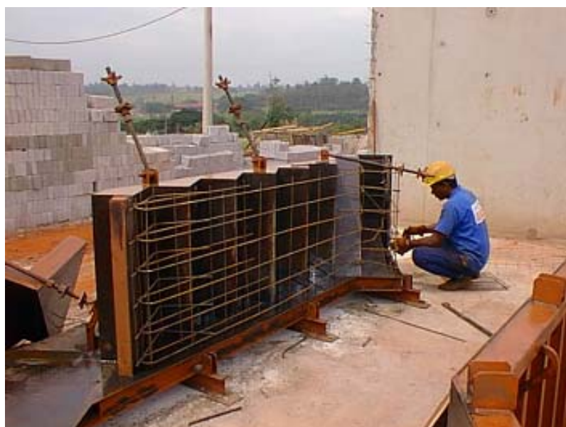
Figura 3.16 – Forma e armadura da escada.
