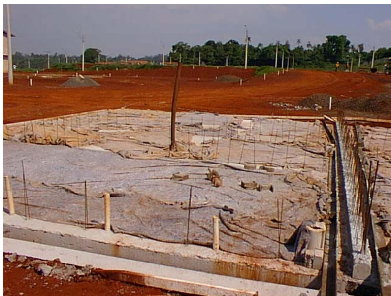
Figura 3.21 – Posicionamento da instalação hidráulica sob a laje de fundação.
