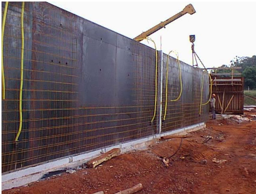
Figura 3.20 – Montagem dos chicotes elétricos.
