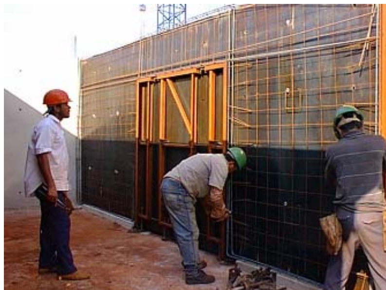
Figura 3.14 – Negativo para uma abertura de passagem.
