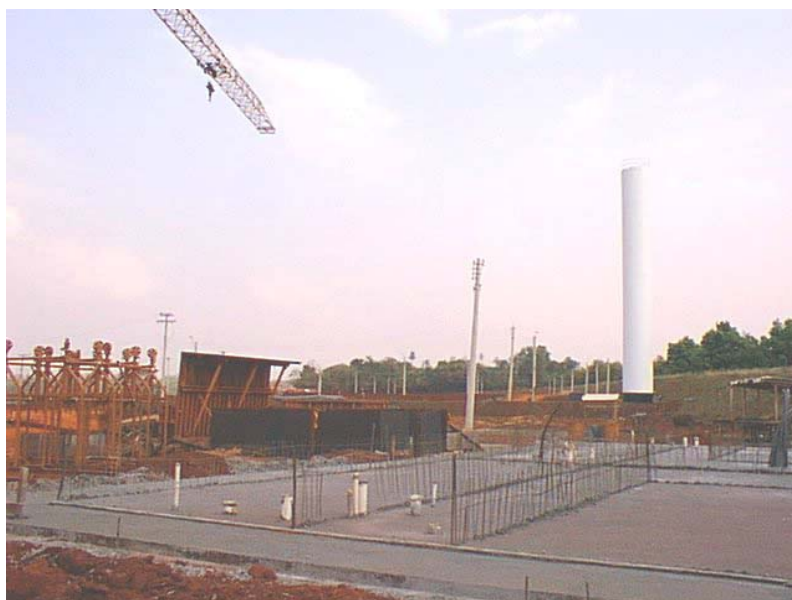
Figura 3.25 – Reservatório central de água.
