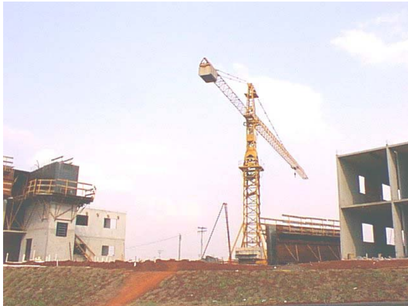
Figura 4.1 – Grua sendo usada para a construção simultânea de dois edifícios.
