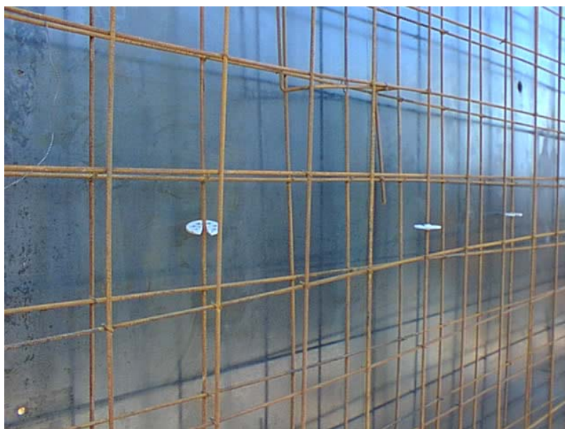
Figura 3.10 – Armadura das paredes e espaçadores.
