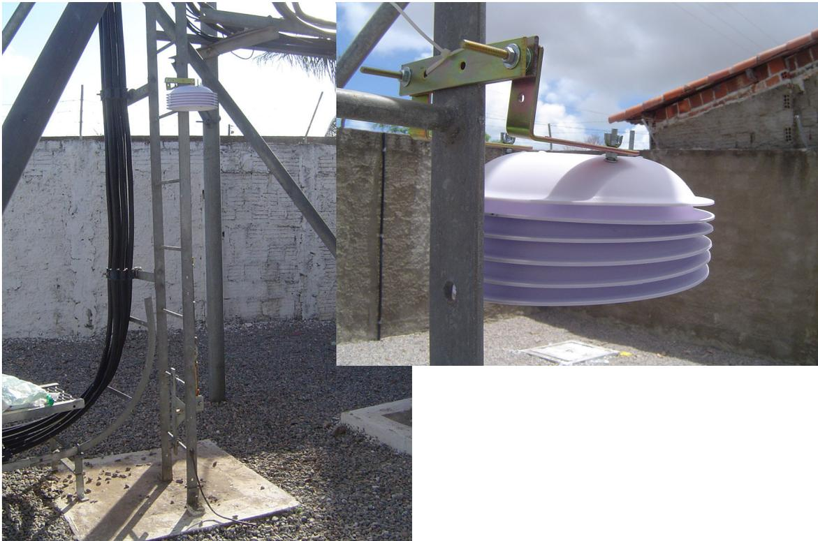
Figura 5.15 – Fotografias do equipamento instalado na escada e detalhe de fixação.
