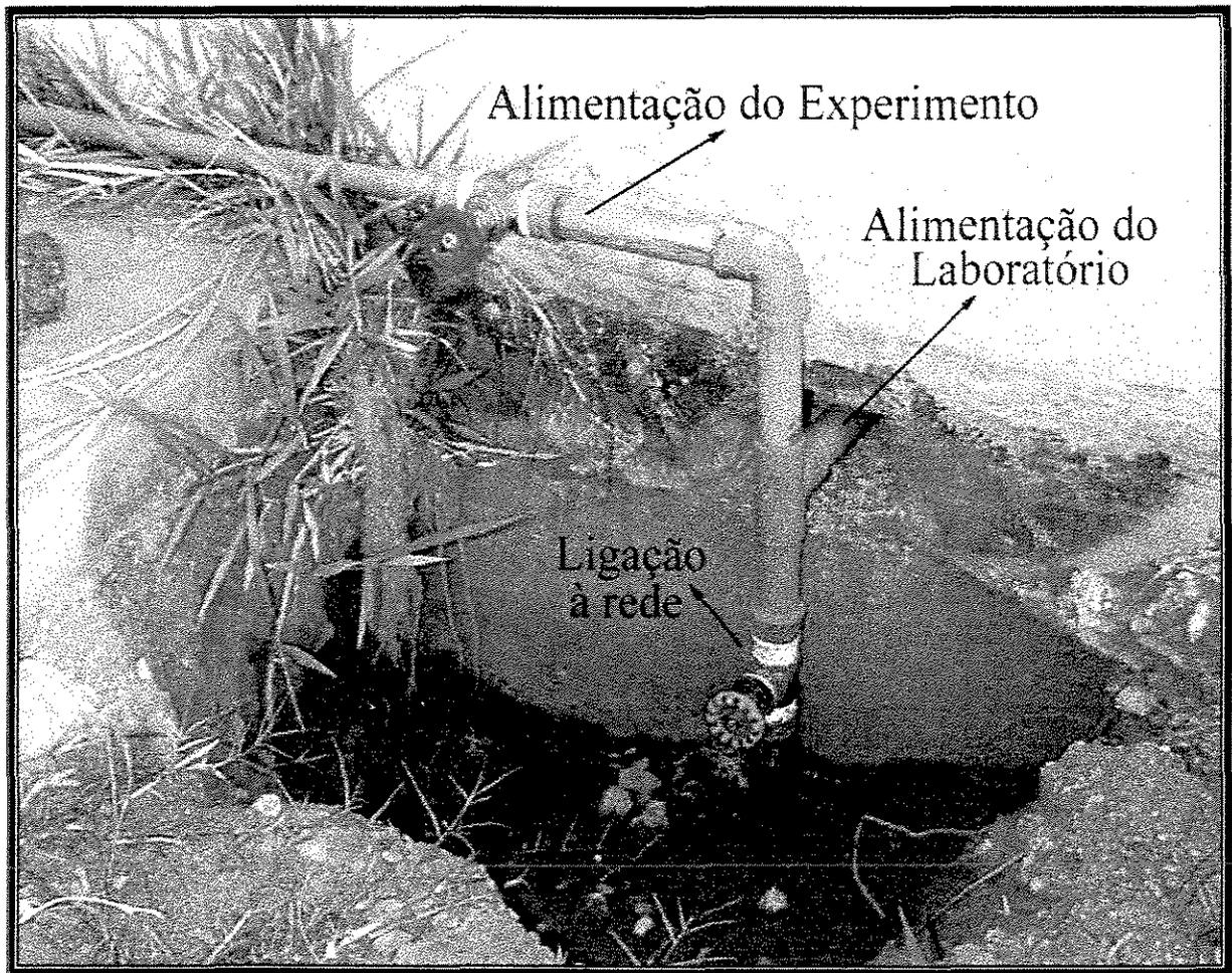
Figura 4.3: Foto da derivação da tubulação, para alimentação do experimento.
