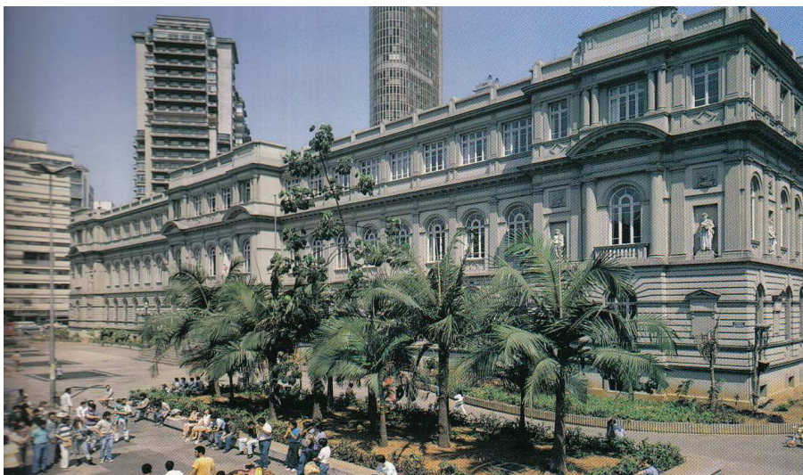
Figura 2.5: Edifício da Secretaria Estadual de Educação de São Paulo, antiga “Escola Normal da Capital”. Fonte: CORRÊA; NEVES; MELLO (1991, p.123).
