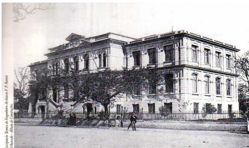
Figura 2.6: Edifício da Escola Modelo da Luz (1897) denominada posteriormente de “Grupo Escolar Prudente de Moraes”.
