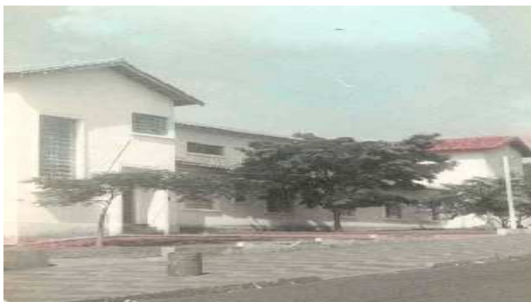
Figura 2.31: Edifício do “Terceiro Grupo Escolar de Campinas”, em 1960. Atual “EE Artur Segurado”
