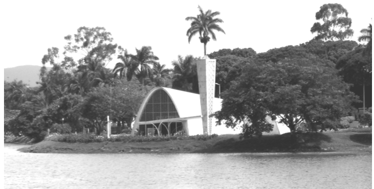
Figura III. 34 Igreja de São Francisco Pampulha - 1942 Fonte: www.vitruvius.com.br/.../arq000/esp011.asp
