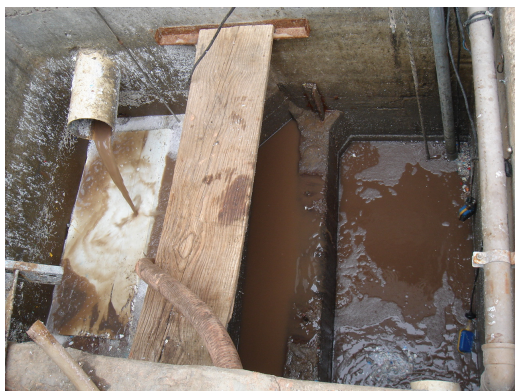
Figura 4.37: VISTA DO POÇO DE SUCÇÃO E RETENÇÃO DE SÓLIDOS GROSSEIROS, APÓS ADAPTAÇÕES Fonte: MENDES (2006)
