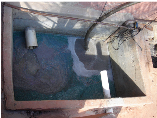
Figura 4.36: VISTA DO POÇO DE SUCÇÃO DE EFLUENTES BRUTOS PRÉ-EXISTENTE Fonte: MENDES (2006)
