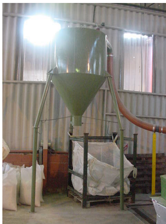
Figura 4.9: VISTA DO SILO CICLONADO PARA SECAGEM DOS PLÁSTICOS PICADOS E LAVADOS Fonte: MENDES (2006)
