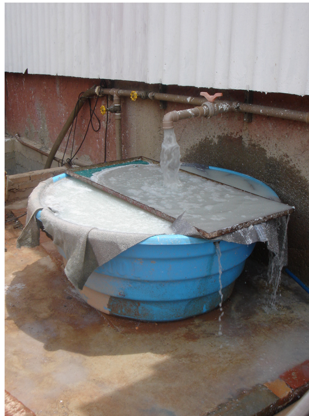
Figura 4.36: VISTA DO POÇO DE SUCÇÃO DE EFLUENTES BRUTOS PRÉ-EXISTENTE Fonte: MENDES (2006)
