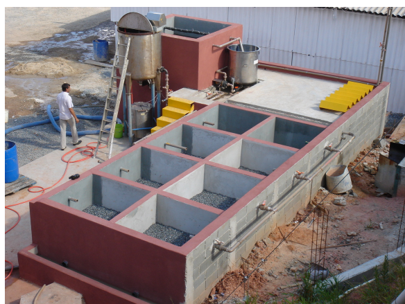
Figura 4.46: VISTA DOS LEITOS DE SECAGEM EM FASE DE CONSTRUÇÃO Fonte: MENDES (2006)
