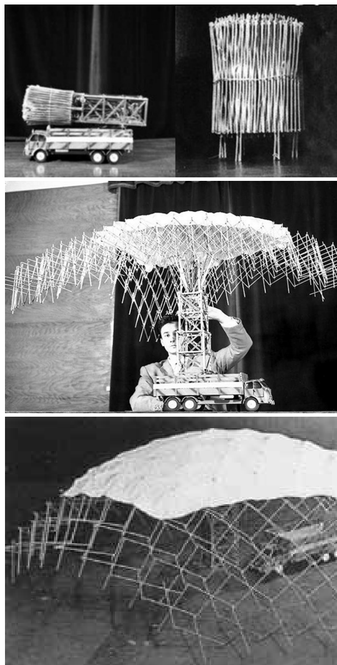
Figura 28. Teatro Móvel - Primeira estrutura tridimensional articulável desenvolvida por Emílio Pérez Piñero (CHURTICHAGA, 2005).
