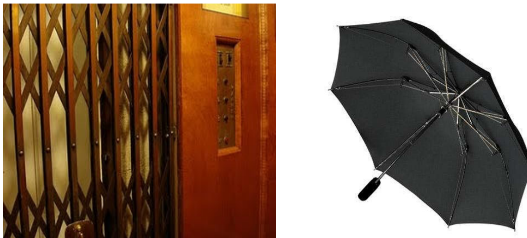
Figura 21. Treliças dobráveis utilizadas em portas de elevadores antigos e em guarda-chuvas (FLICKR, 2009).
