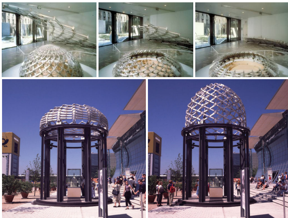
Figura 13. Instalação da cúpula articulável 'Iris Dome' no Museu de Arte Moderna de Nova York em 1994 e na Feira de Hanover em 2000 (HOBERTMAN, 2009).
