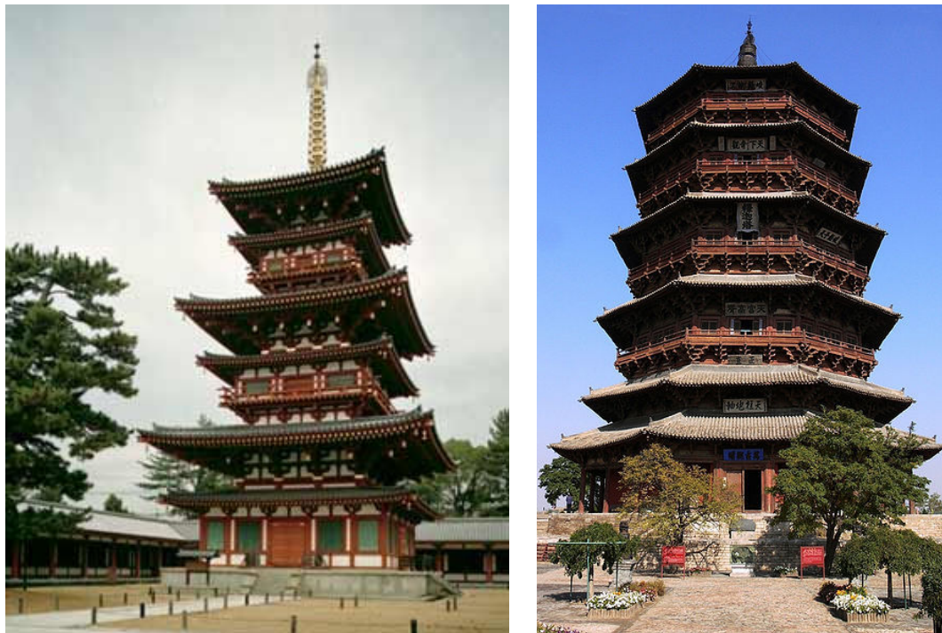
Figura 46. Pagoda Yakushiji Toto, construída no Japão em 730 e Pagoda Sakyamuni do Templo de Fugong, construída em 1056, respectivamente (STEINHARDT, 1997; CLUZEL, 2007).
