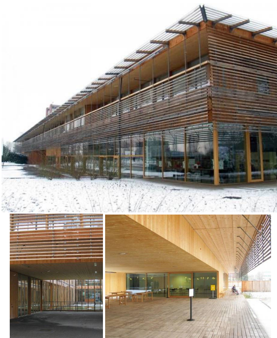
Figura 52. Clínica de reabilitação projetada por Herzog e De Meuron na cidade de Basel, Suíça (DANDA, 2010).
