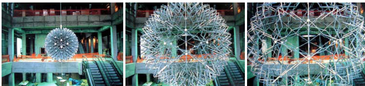
Figura 12. Expansão da esfera cujo diâmetro aumenta de 1,4m para 5,9m (HOBERTMAN, 2009).
