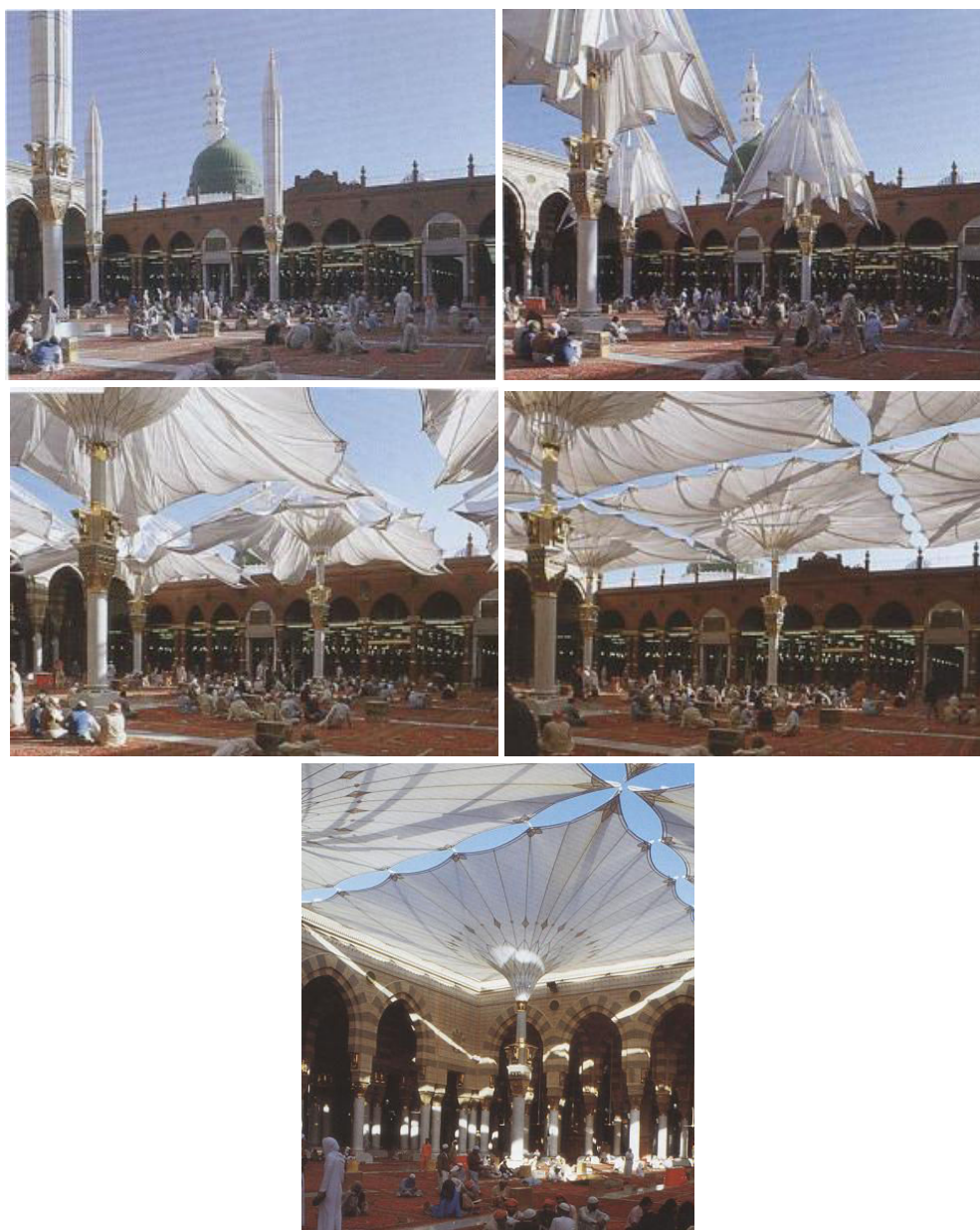
Figura 41. Cobertura do tipo guarda-chuva construída em uma mesquita em Madinah, Arábia Saudita (WALTER, 2006).
