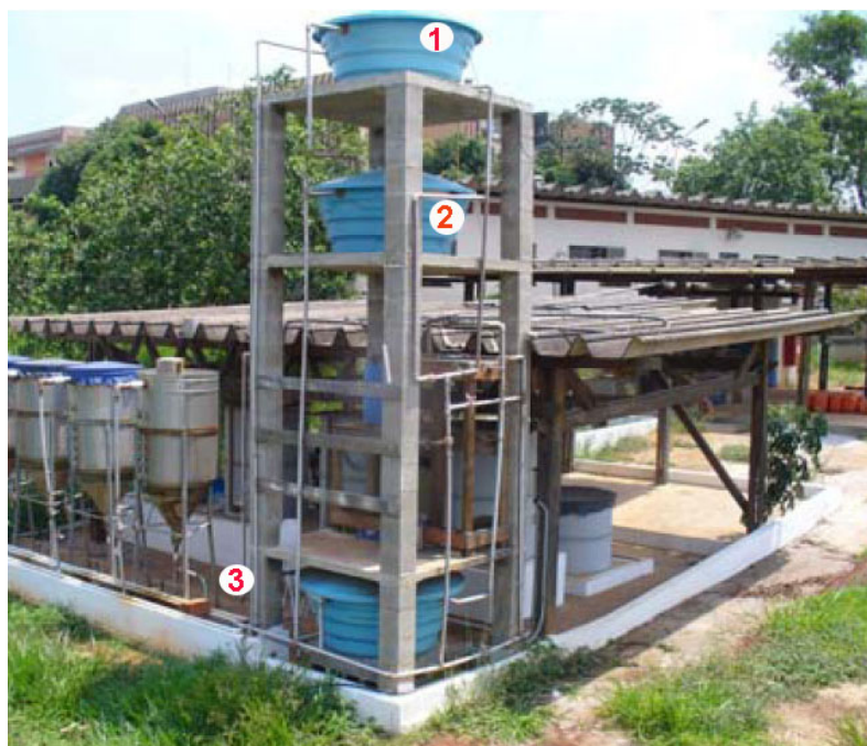
1 - caixa primária; 2 - caixa secundária; 3 - ponto de coleta de amostras (local onde se coletava o esgoto bruto utilizado no sistema de estudo)
