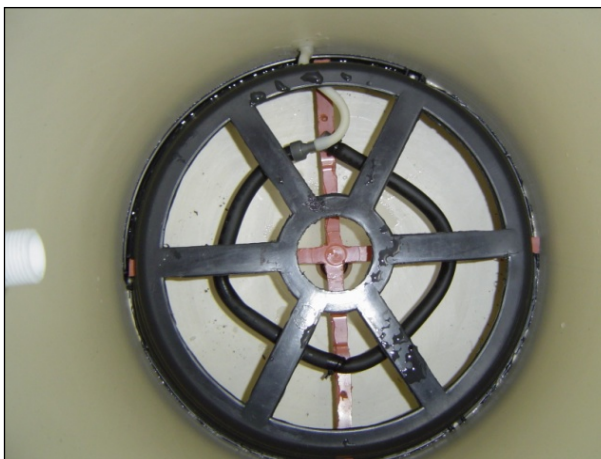
Figura 4-3 Fundo falso do biofiltro aerado submerso
