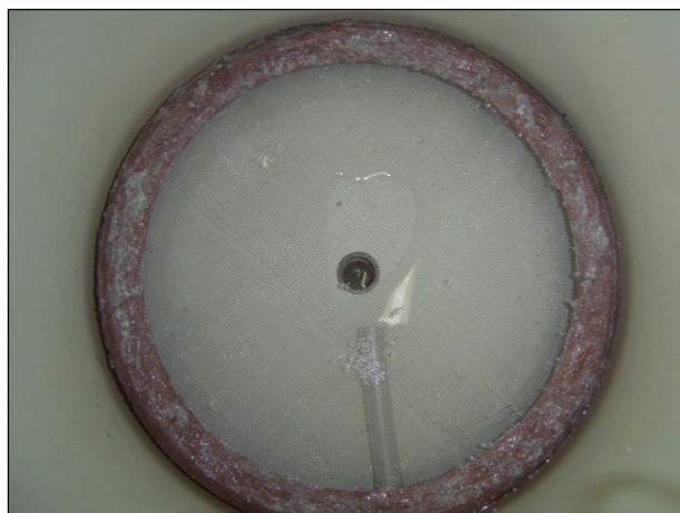
Figura 4-2 Fundo falso do filtro anaeróbico
