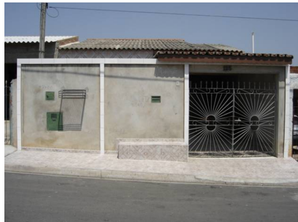
Figura 24 - Banco na calçada São José
