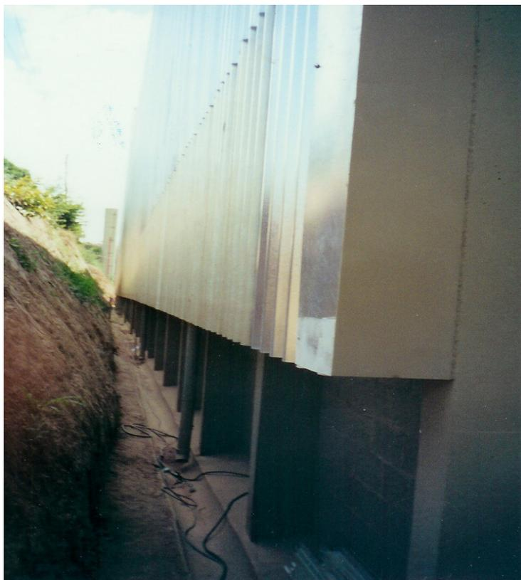
Fig. 38 – Detalhe do fechamento vertical em telhas de aço.
