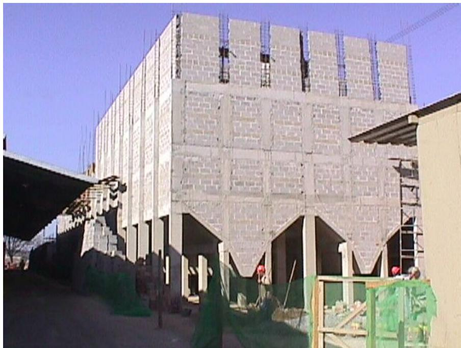
Fig. 33 – Perspectiva da construção do silo.
