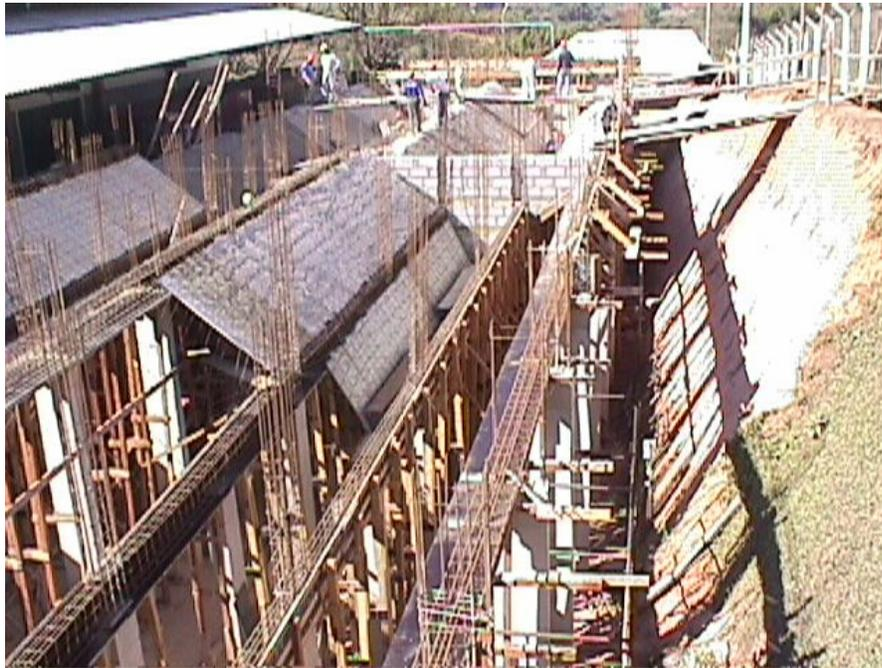
Fig. 36 – Detalhe da construção da tremonha
