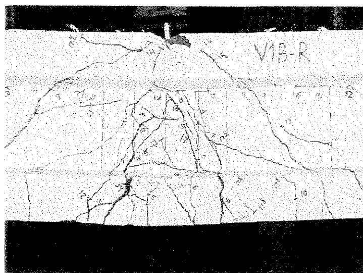
FIGURA 6.25 Fissuração na região de volume comum na viga suporte
