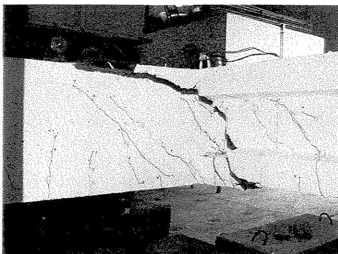
FIGURA 6.5 Ruptura na região de ligação entre as vigas
