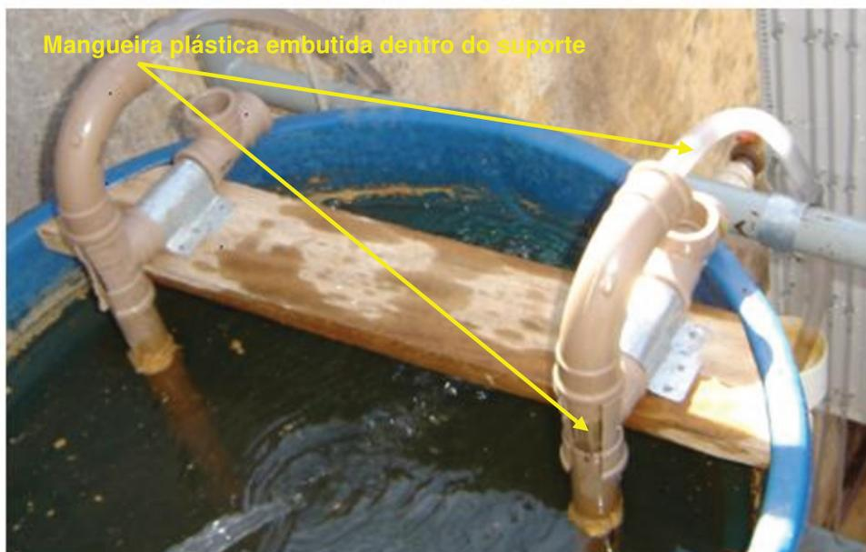
**Figura 4.12 - Fotografia do sistema controle de vazão por sifonamento**
