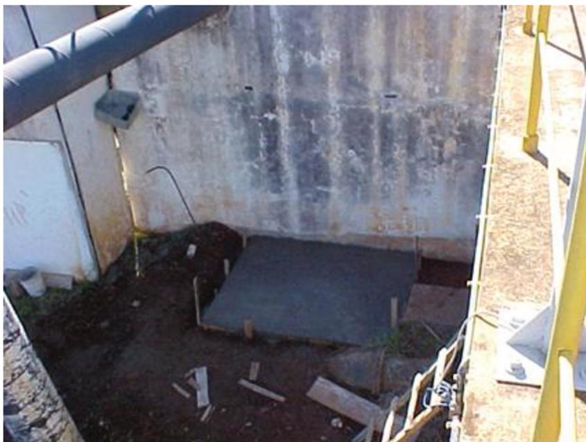
**Figura 5.4 - Fotografia mostrando a base em concreto para instalação da plataforma**
