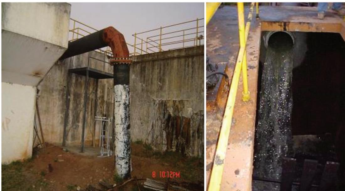
**Figura 5.14 - Fotografias, vista externa e interna, do canal de entrada de água coagulada nos floculadores**
