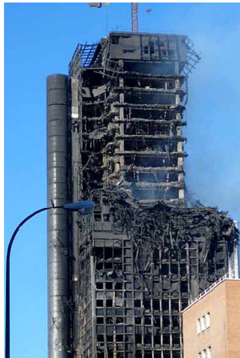
Figura 1.3 – Incêndio na Torre Windsor em Madri e dano causado após o sinistro – colapso parcial, 2005 (9 – 11 RESEARCH, 2005).
