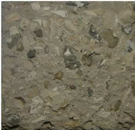
Concreto preparado com agregado Calcáreo - C20 - 5.0cm - P3
