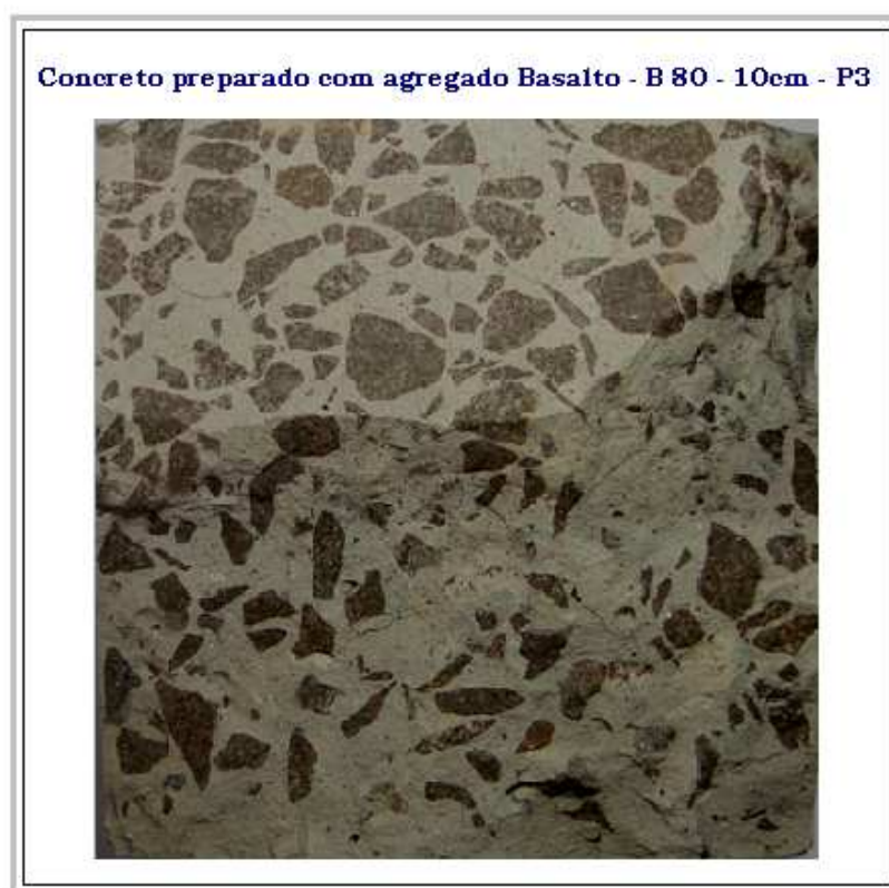
Figura 7.5 – Detalhe da superfície da face aquecida da placa de concreto de 80MPa e 10cm de espessura preparada com agregado basalto e detalhe do lascamento explosivo de parte da superfície.
