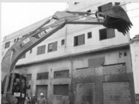
Figura 22: Demolição Nova Luz Fonte: Ssp.sp.gov.br
