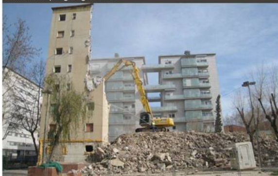
Figura 8: Demolição em Sant Roc fonte: Generalitat Catalunya | gencat.cat
