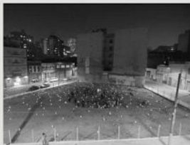
Figura 23: Demolição Nova Luz Fonte: midiaindependente.org
