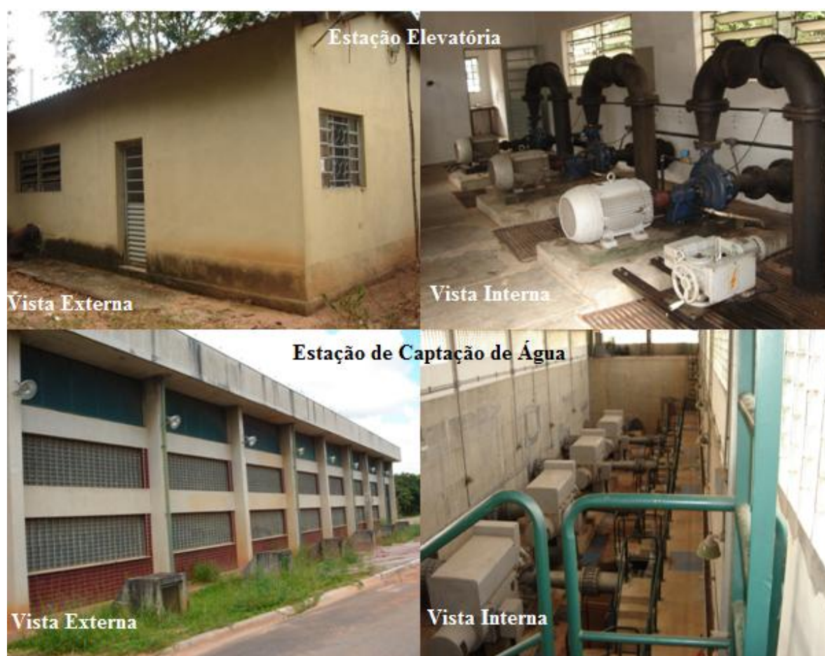
Figura 5.6: Vistas interna e externa de uma estação elevatória e de uma estação de captação de água
