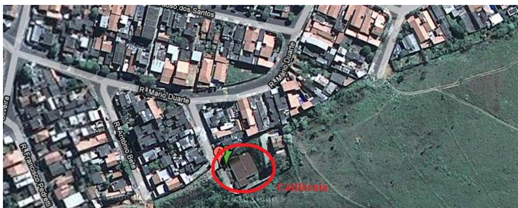
Figura 7.63: Foto aérea da Estação Elevatória Califórnia (Google Earth, acessado em março de 2010)
