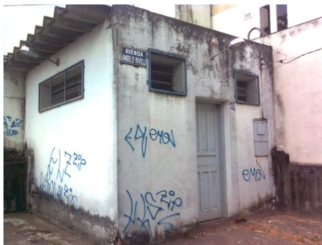
Figura 7.23: Vista externa de Estação Elevatória Jardim da Fonte (Arquivo Pessoal)
