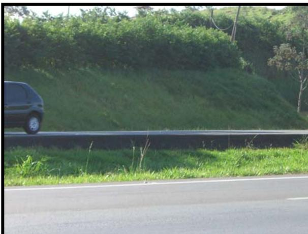
Foto 5 – Degrau acentuado entre a pista e o canteiro central
