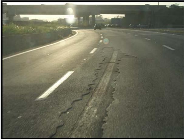
Foto 1 – Pavimento com soltura do microrevestimento
