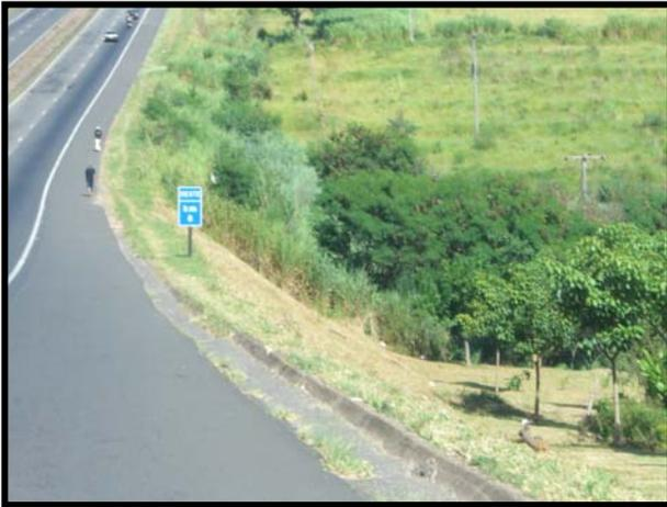
Foto 19 – Falta de proteção lateral em talude íngreme
