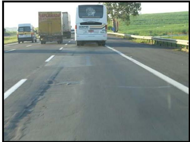
Foto 2 – Pavimento com deformidade na faixa (permitindo o acúmulo de água)
