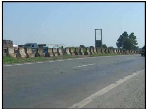
Foto 24 – Proteção deficiente com barreiras de concreto
