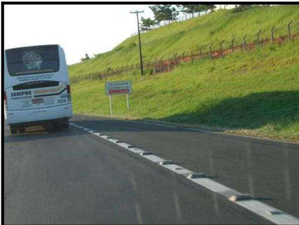
Foto 15 – Sinalização horizontal deficiente – tachões em faixas longitudinais
