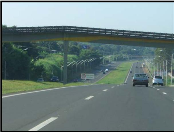
Foto 21 – Falta de proteção lateral em passarelas
