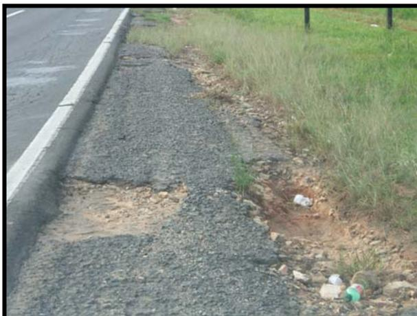
Foto 6 - Degrau acentuado entre a pista e o acostamento
