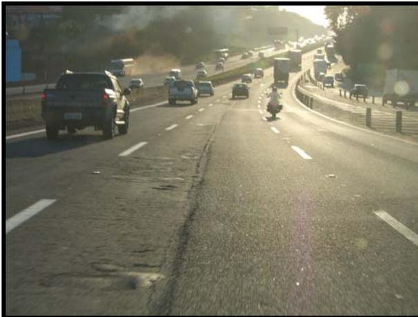
Foto 3 – Pavimento deteriorado com afundamento
