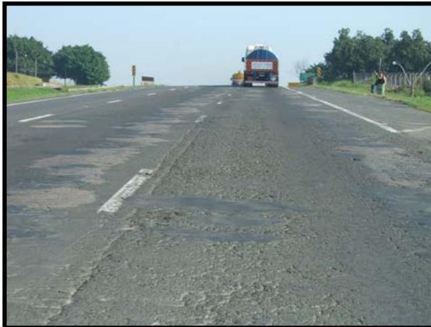
Foto 4 – Pavimento com trincamento severo, início de buracos e deformidades
