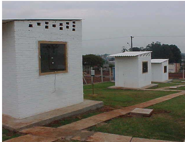
FIGURA 102 – Células-teste com vidros instalados
