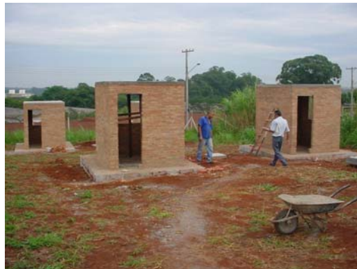
FIGURA 97 – Células-teste em construção (julho/2003)
