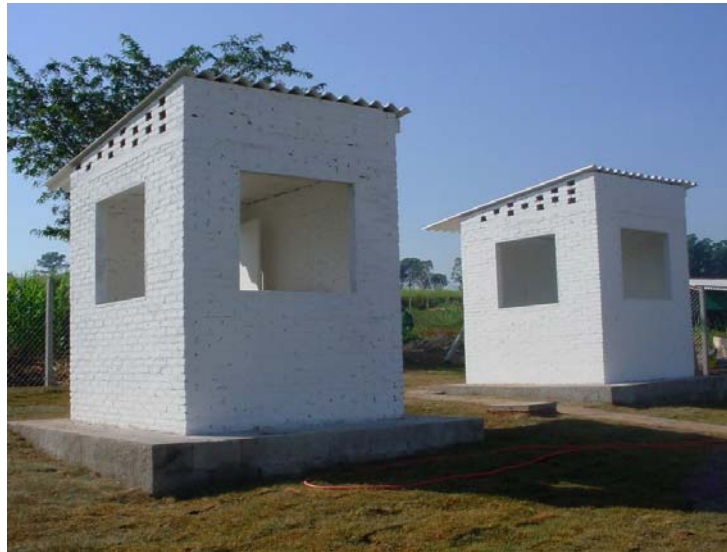
FIGURA 15 – Vista das células-teste em construção
