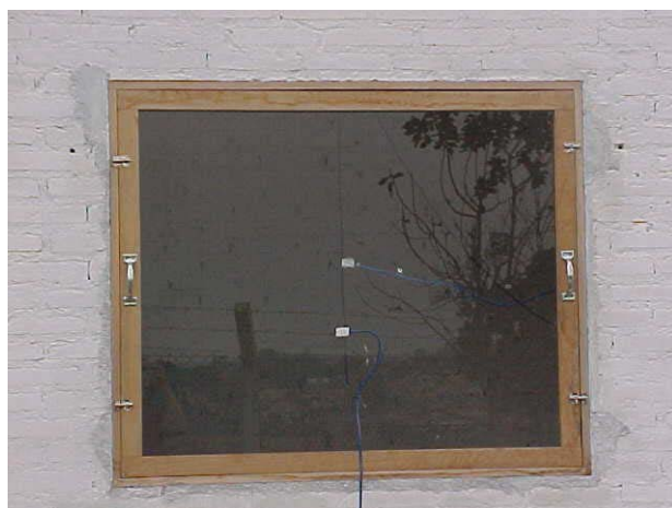
FIGURA 101 – Janela com moldura e vidro instalados (abril/2004)
