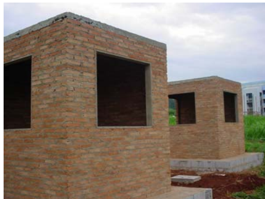
FIGURA 98 – Vista das janelas (em construção – julho/2003)
