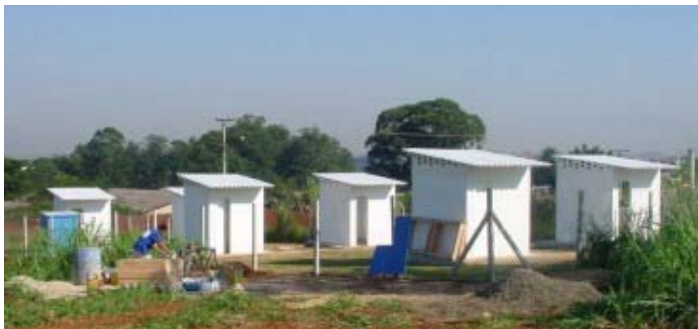
FIGURA 10 – Vista geral das células-teste, em fase final de construção
