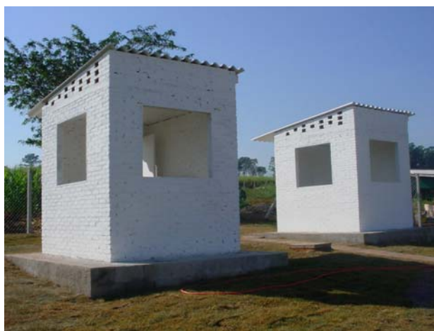
FIGURA 100 – Células-teste (final de construção – fevereiro/2004)
