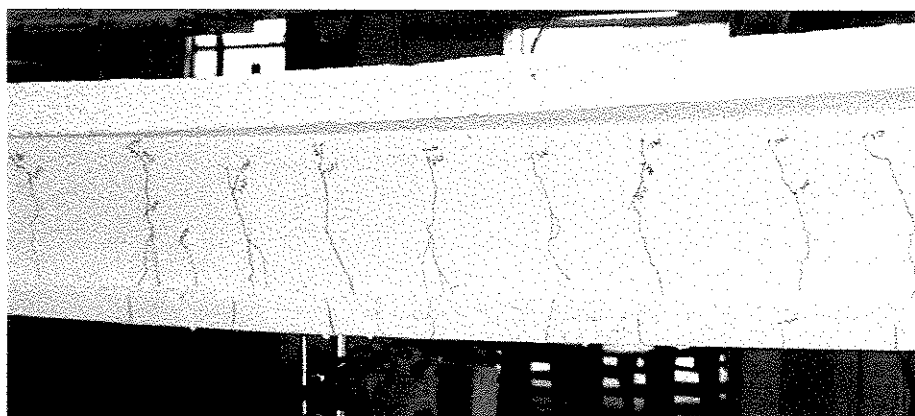
FIGURA 5.29- Configuração de fissuras para viga V201.
