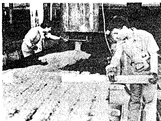
FIGURA 2.8- Lançamento do Concreto [22]
