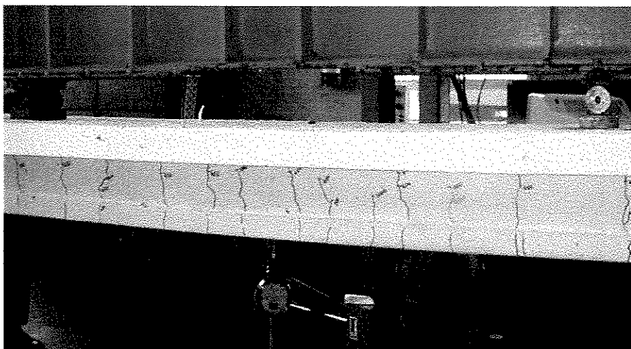
FIGURA 5.27 – Configuração de fissuras para V161- Vista frontal.
