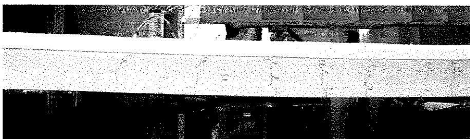
FIGURA 5.28- Configuração de fissuras para viga V 162. Vista posterior.
