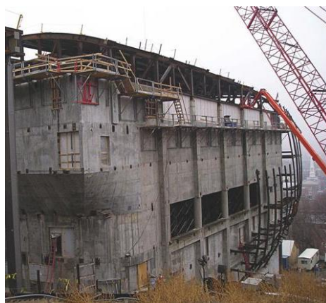
(c) Construção do bloco norte.
