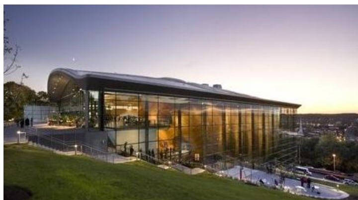
Figura 6.44. EMPAC, vista para o rio Hudson.
