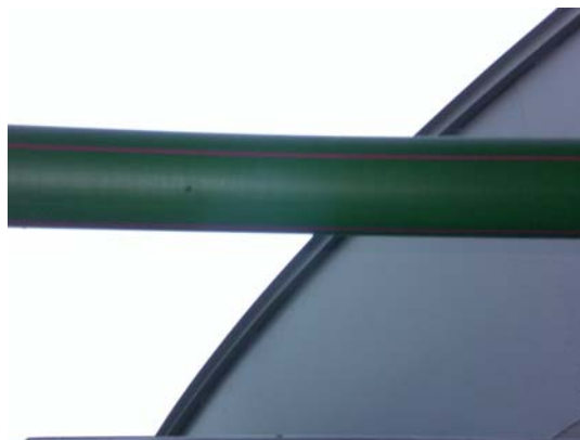
Figura 4.7 – Identificação da rede de tubulação de reúso
