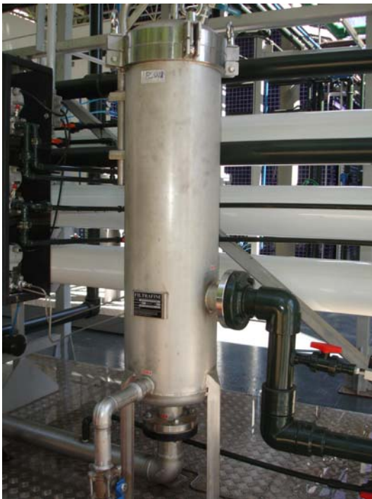
Fig. 4.15 - Unidade contendo 12 filtros de cartuchos
