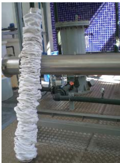
Fig. 4.14 - Detalhe do filtro manga
