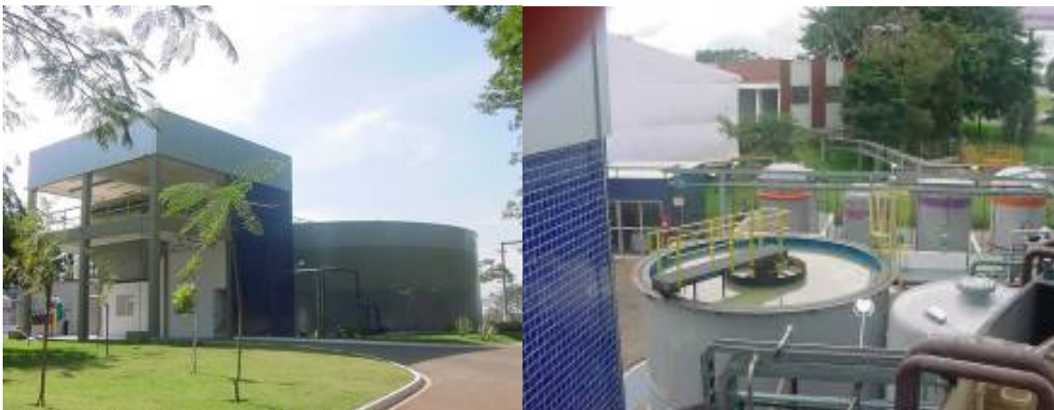
Figura 4.1 – Vista da Estação de Tratamento de Efluente
