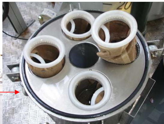
Fig. 4.20 - Filtro da saída do tanque
